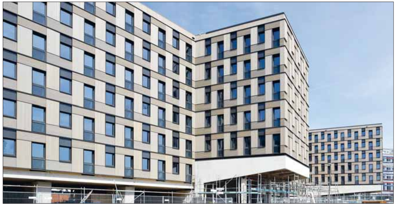
Das siebengeschossige Studierendenwohnheim namens „Woodie“ in Hamburg-Wilhelmsburg ist derzeit das weltweit größte Bauvorhaben in Modulbauweise. Die 20 m 2 großen Apartments wurden samt Inneneinrichtung im Werk vorgefertigt und per LKW auf die Baustelle geliefert. Die 371 Module sind aus Brettsperrholz gebaut. Foto: Kaufmann Bausysteme
