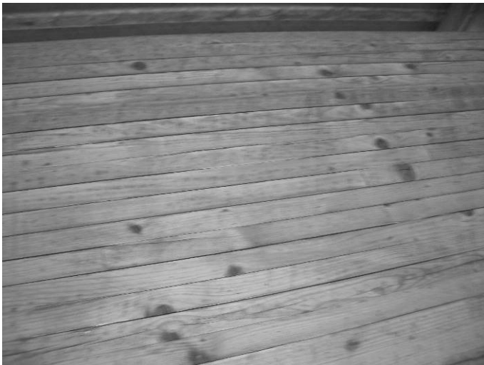
Abbildung 13: Umfangreiche Rissbildung in einer Eissporthalle BJ. 1990
