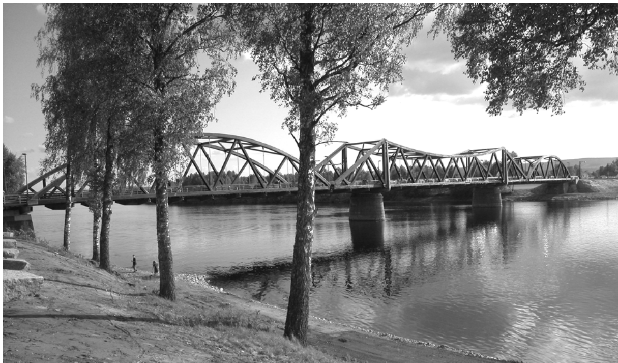
Bild 1 Die neue Flisa Brücke
