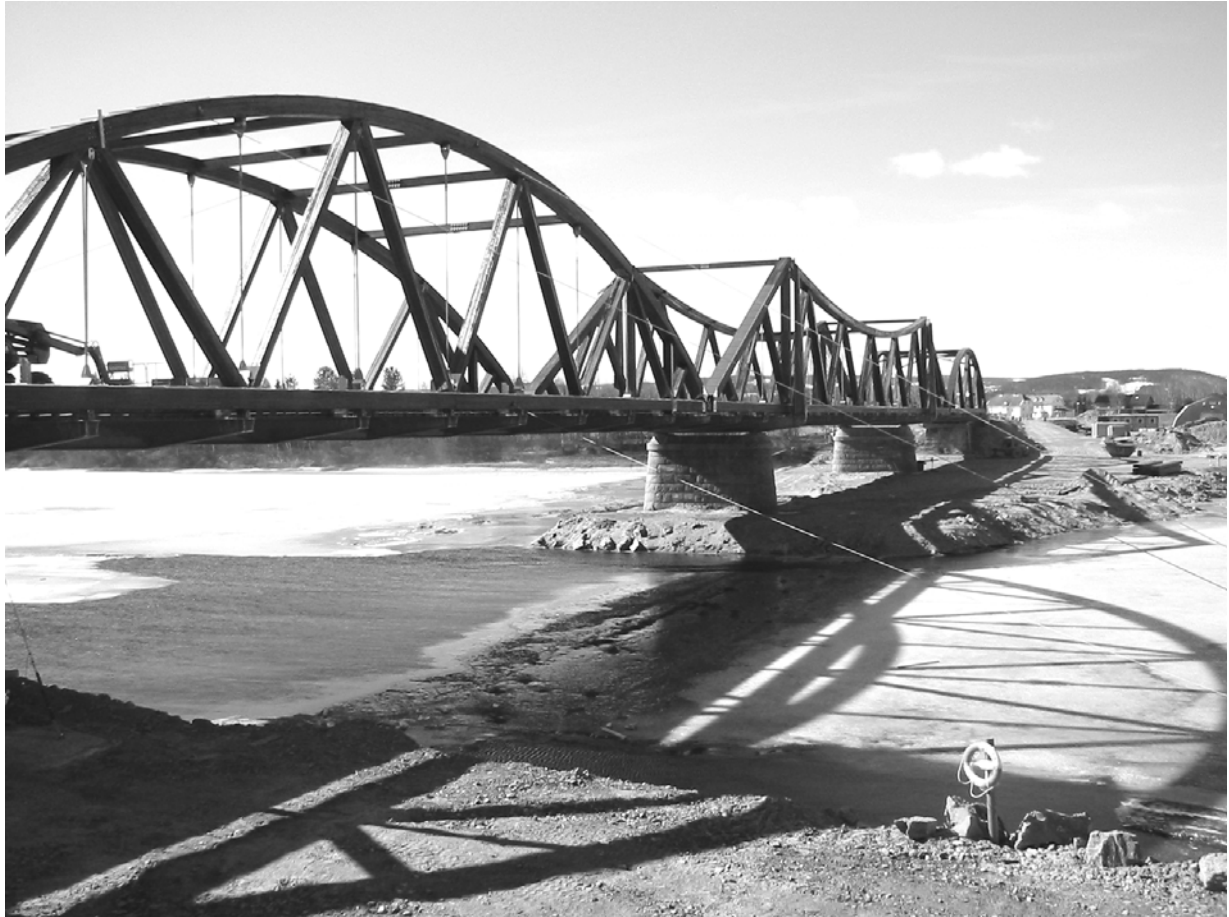
Bild 6 Temporäre Damm für den Bauzustand
