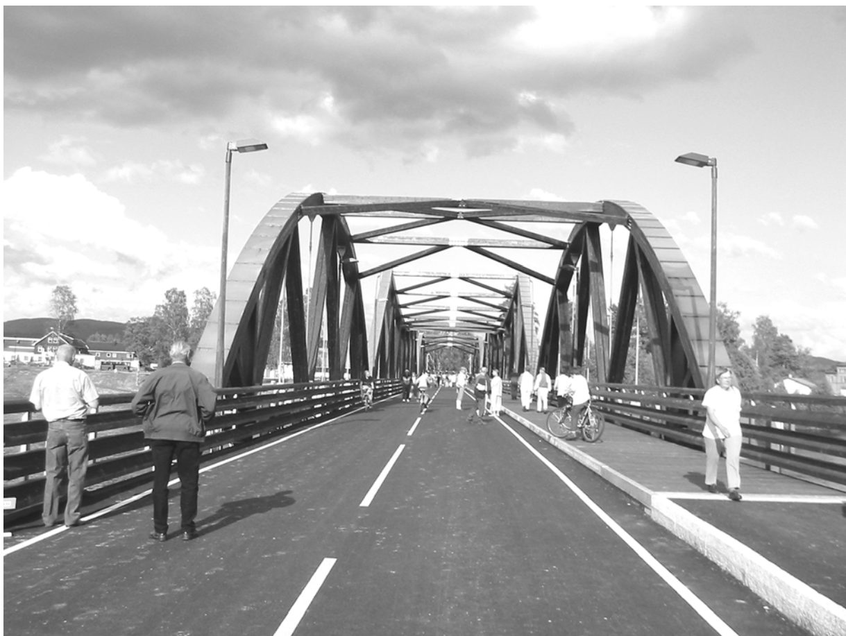
Bild 7 Die Flisa Brücke nach der Eröffnung
