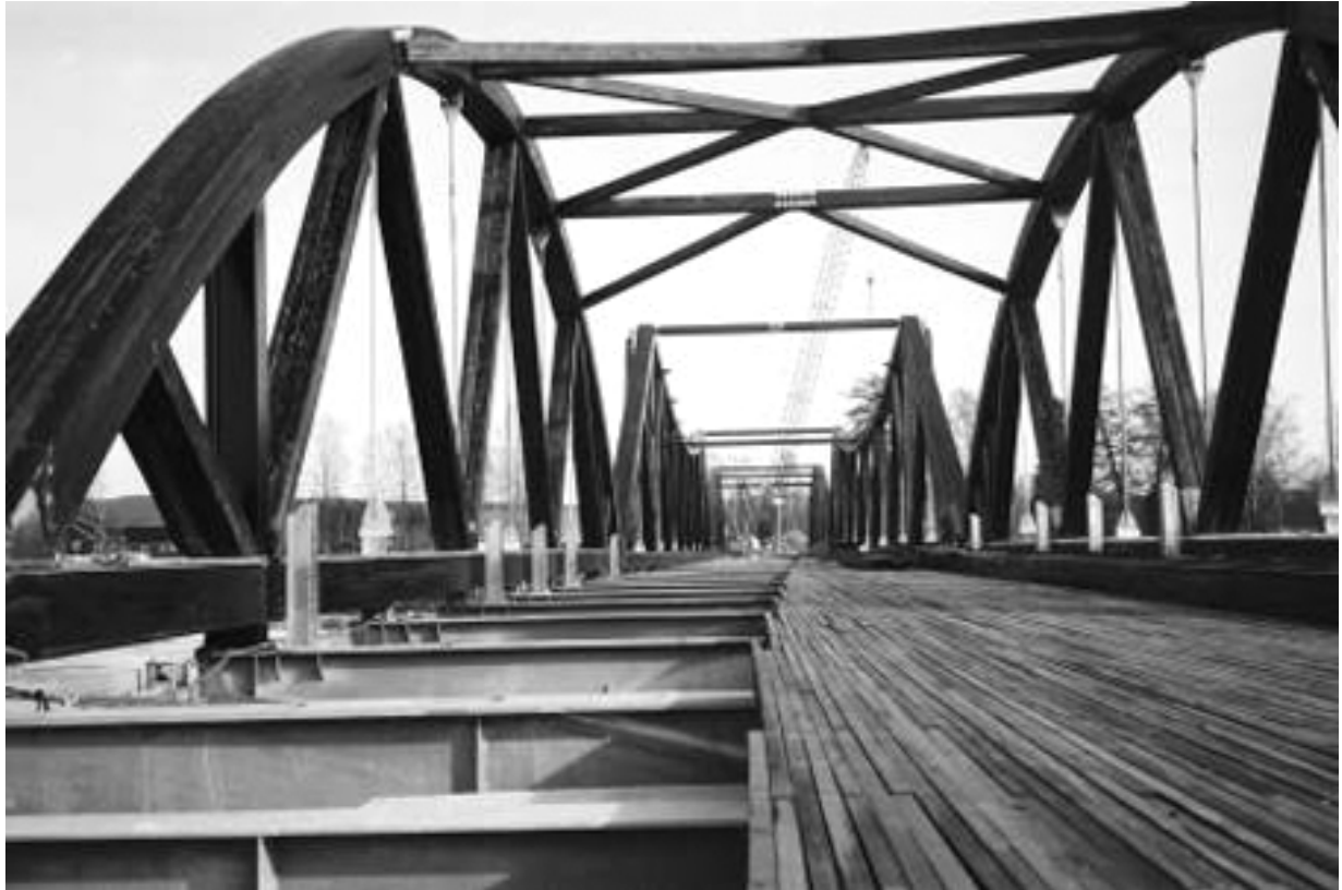
Bild 5 Auslegen der quer vorgespannten Decke
