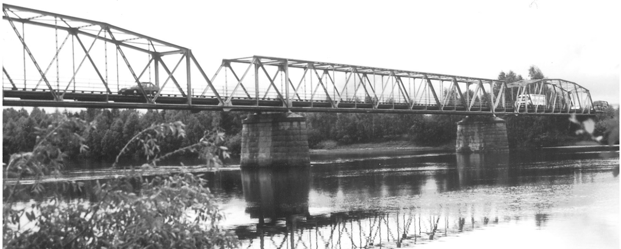
Bild 2 Die alte Stahlbrücke
