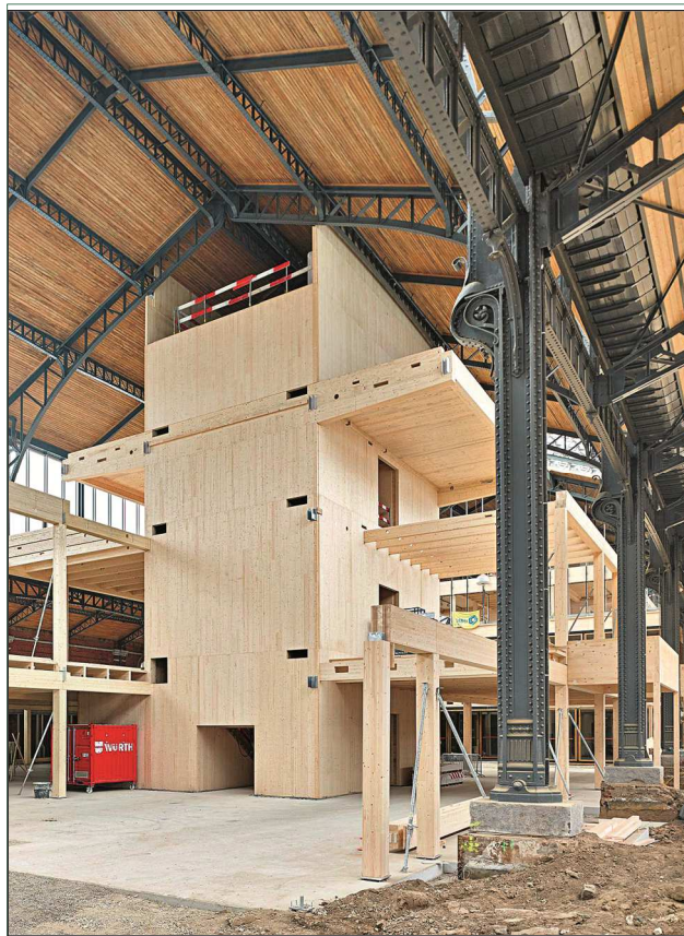
6020 m 3 Brettspertholz wurden beim Gare Maritime in der nördlichen Innenstadt von Brüssel verbaut, was etwa zwei Drittel des insgesamt verbauten Holzvolumens darstellt.
