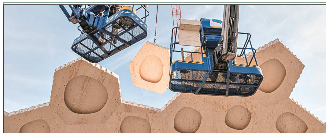
376 großformatige Holzkassetten mit polygonalen Formen bilden den Holzpavillon. Das geringe Gewicht der Schalensegmente sowie eine kraft- und formschlüssige Verbindung untereinander ermöglichen eine Montage im freien Vorbau. Fotos (2): ICD-ITKE
