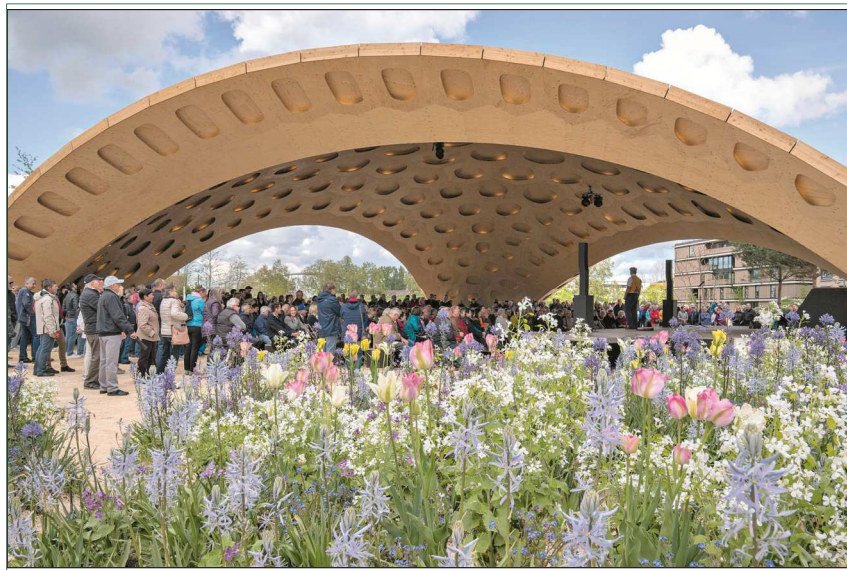
Mit minimalem Materialeinsatz überspannt der Pavillon etwa 30 m und schafft so einen einzigartigen architektonischen Raum. Foto: Buga Heilbronn 2019 GmbH
