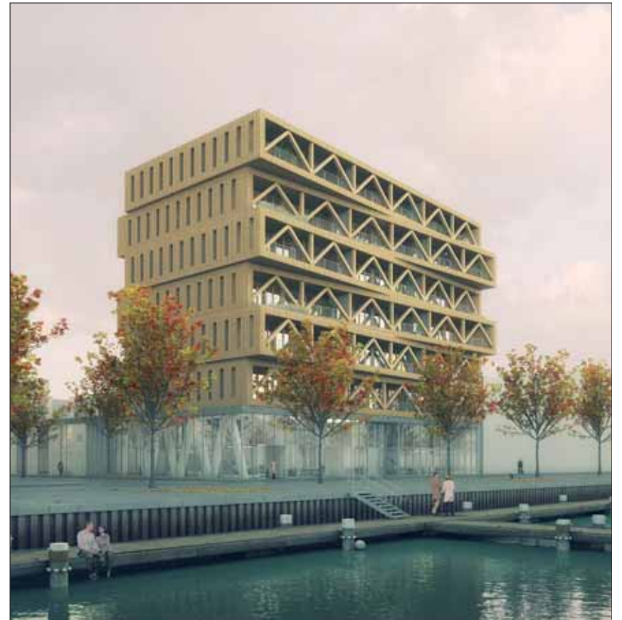
Tom Frantzen stellte mit der „Patch 22 Residence“ in Amsterdam den ersten Siebengeschosser in Holzbauweise vor, der in den Niederlanden entstehen wird und zudem ein ambitioniertes Energiekonzept aufweist Abbildung: Frantzen
