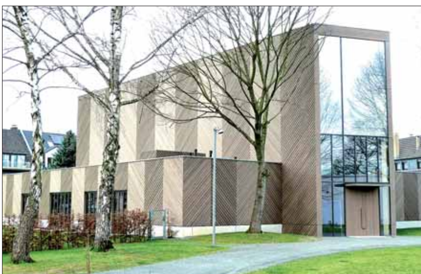
Im Rahmen des EBH-Kongresses konnten interessierte Planer das neue Gemeindezentrum in Köln-Stammheim besuchen; dessen Holzarchitektur erhielt 2014 den Deutschen Holzbaupreis sowie 2015 den Deutschen Architekturpreis Foto: S. Klein
