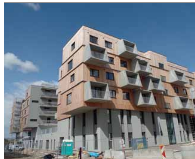
Dieser Gebäudekomplex im Wiener Stadtentwicklungsgebiet „Seestadt Aspern“ wurde in Holzbeton-Hybridbauweise errichtet und mit einer hinterlüfteten Lärchenholzfassade versehen Foto: LC Buildings GmbH
