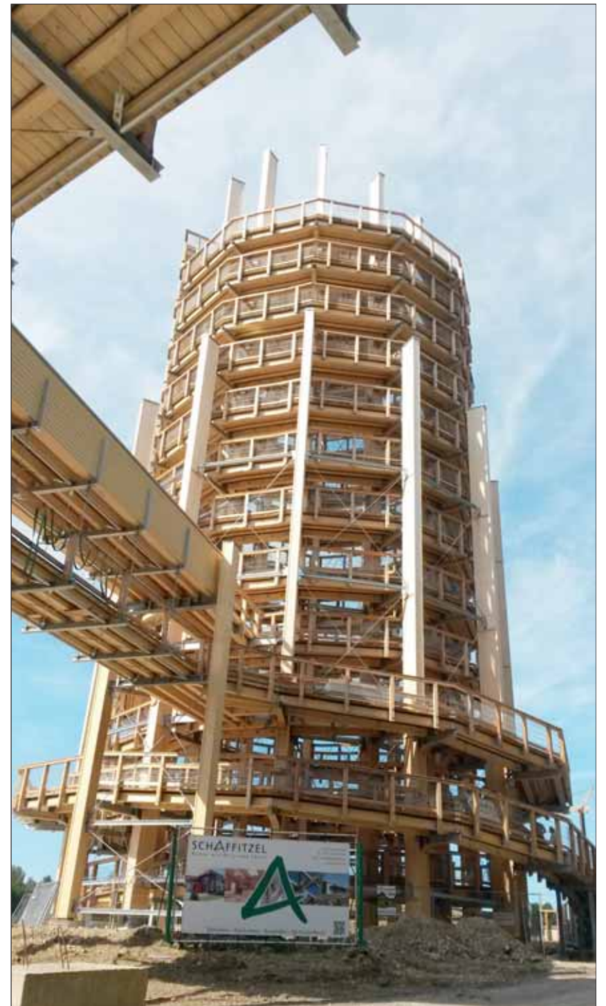
Der Baumwipfelpfad des Naturerlebnisparks „Panarbor“ bei Waldbröl ist mit seinem 40 m hohen Aussichtsturm und dem 1200 m langen, aufgeständerten Wipfelpfad ein ambitioniertes Holzbauprojekt, das seit September 2015 der Öffentlichkeit zugänglich ist Foto: Ingenieurbüro Miebach
