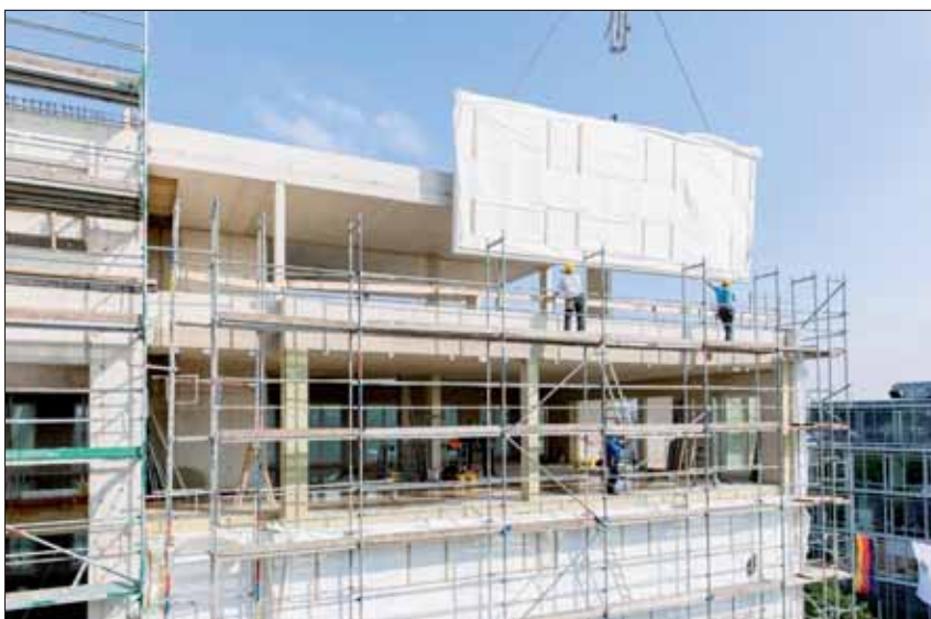
Das neue „Rheinpalais Bonner Bogen“ nahe des Rheins zeigt die Möglichkeiten der Holzbeton-Hybridbauweise in einem großen Rahmen auf, dessen Rohbau derzeit mit etwa 30000 m 2 Holztafelementen inkl. Fenstern wetterfest geschlossen wird Foto: Bernd-Michael Maurer/Ewald Hohn Projektentwicklung
