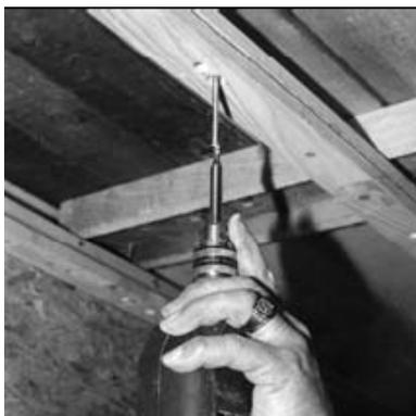
Bild 14: Befestigung Beplankung
