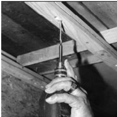
Bild 13: Befestigung Deckenprofil
