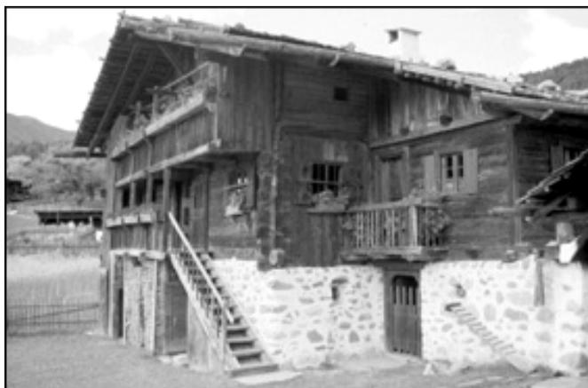
Beispiele von über 500 Jahre alten Bauernhäusern (Bild) belegen, dass im alpinen Raum - insbesondere in den höheren Lagen - schon immer sehr viel in Holz gebaut wurde. Der Unterbau eines Hauses war in Steinmauer erbaut, der Wohntrakt in Holz. Dabei trifft man fast ausschließlich auf die Blockbauweise.
