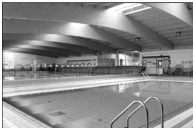
Erst seit einigen Jahrzehnten begannen italienische Projektanten und Bauherren Hallen, Schwimm- und Sportstätten in Holz zu bauen (Bild). Dafür wurde vornehmlich Brettschichtholz (Leimholz) verwendet. Dies ist seitdem der wichtigste Bereich, in dem Holz beim Neubau eingesetzt wird, während die Verwendung von Holz für öffentliche Bauten wie Museen und Theater aufgrund der strengen Brandschutzbestimmungen in den vergangenen Jahren fast gänzlich ausgeblieben ist.
