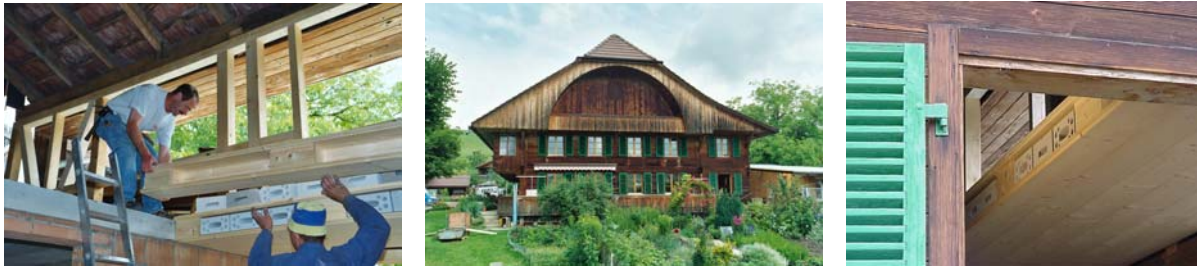
Abbildung 6 und 7 und 8: Sanierung - Bauernhaus Stauffer, Fahmi / CH
