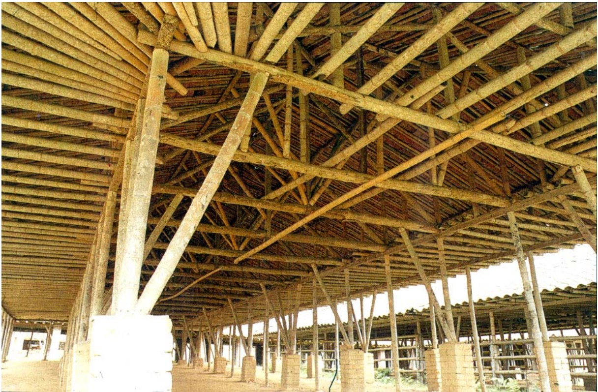
Halle in Risaralda, Kolumbien. Offene Bambuskonstruktion mit Ziegeldach.
