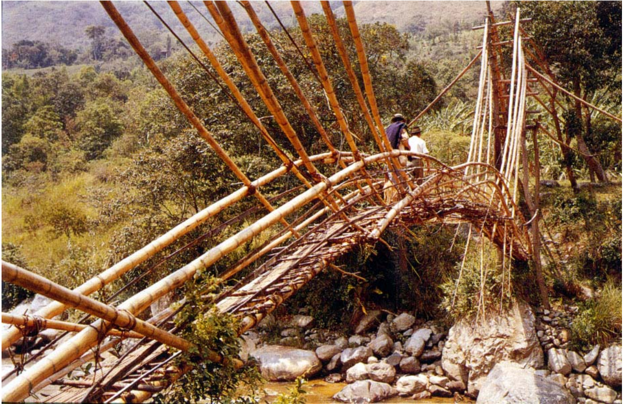
Hängebrücke in Tierradentro, Kolumbien. Eines der wenigen Beispiele für zugbelastete Bambuskonstruktionen.
