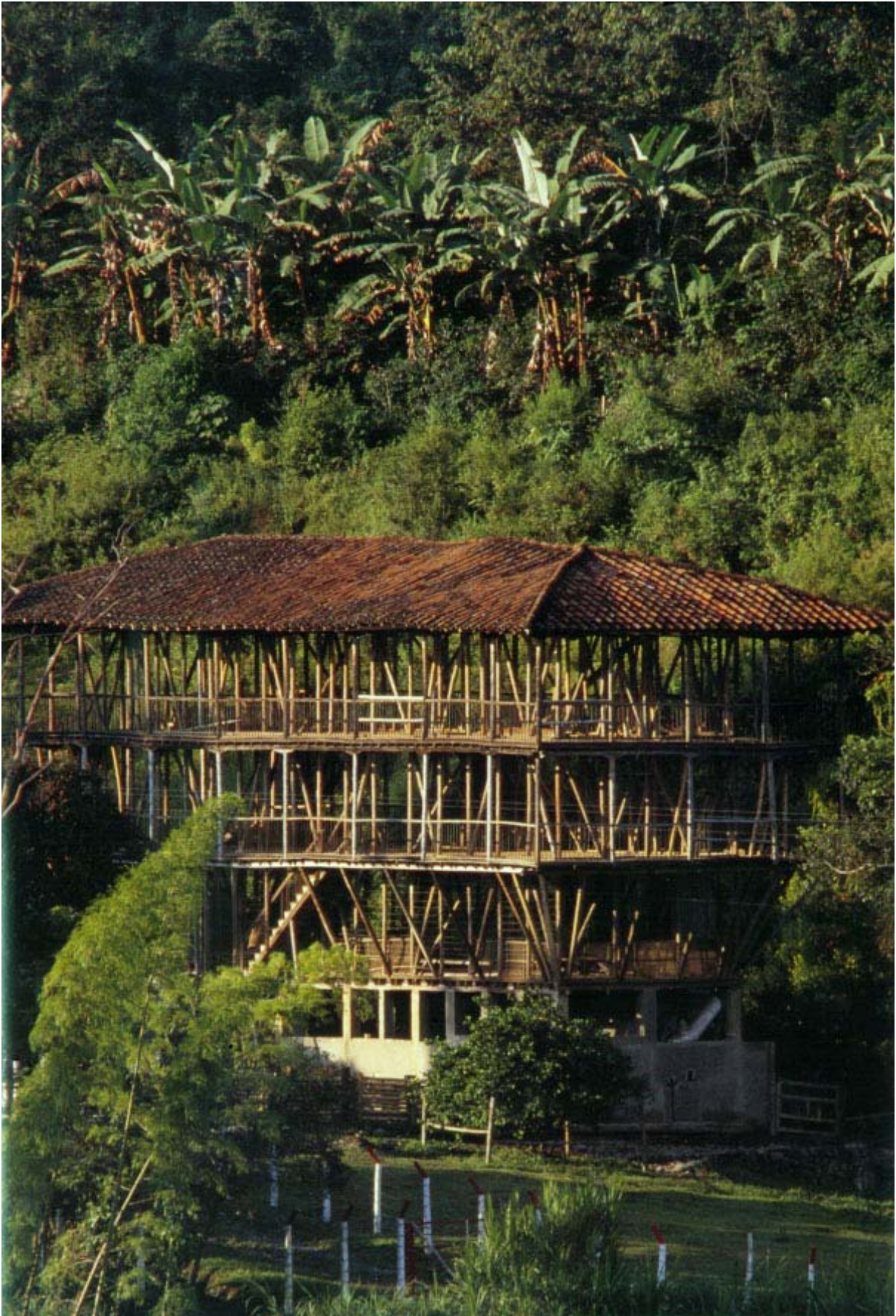
Vierstöckiges Gebäude zur Kaffeetrocknung; Mischkonstruktion aus Holz und Bambus; Caldas, Kolumbien.
