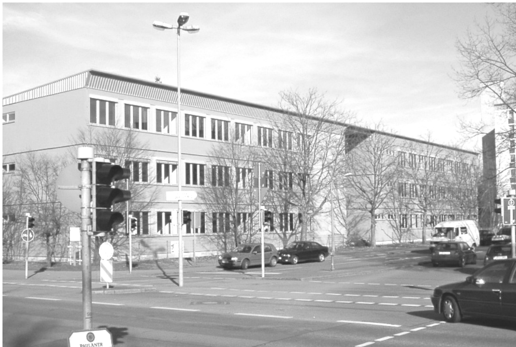
Abbildung 10: Fertiggestelltes Interimsgebäudes am 21. Januar 2002
