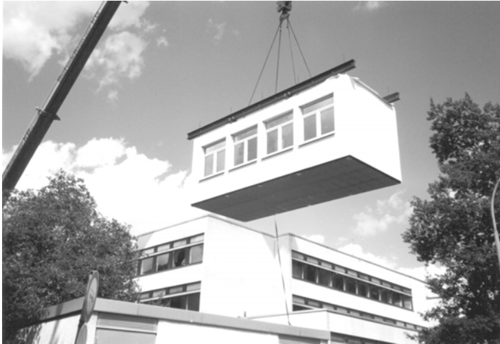
Abbildung 9: Versetzen eines Raumelementes
