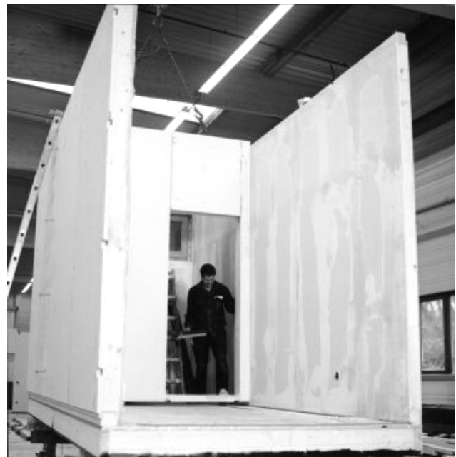
Abbildung 3: Montage der Wandelemente zu einem Raummodul
