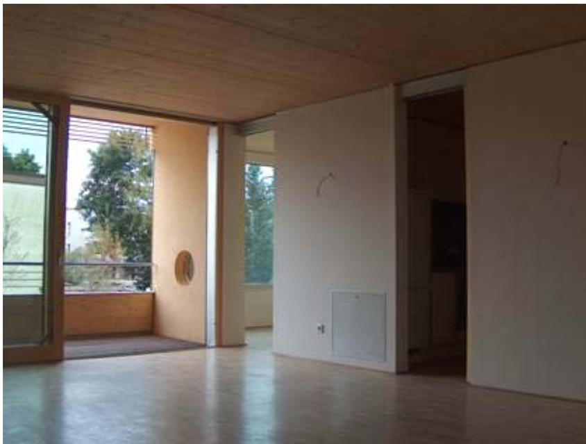
Abbildung 3: Innenansicht einer Wohnung mit Unteransicht der Deckenelemente und Fußbodenaufbau mit Parkettbelag
