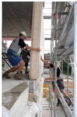
Abbildung 16: Montage Aussenwandelement
