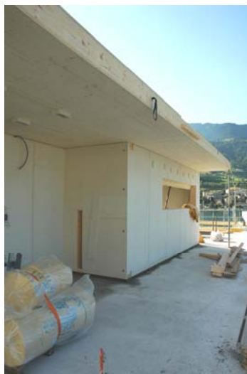
Abbildung 13: Aussenansicht Küchenfenster Attika
