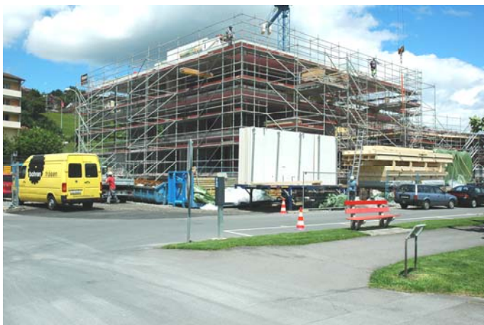
Abbildung 11: Ansicht Haus 19 während der Montage des Attikageschosses
