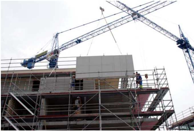
Abbildung 14: Montage der Aussenwandelemente zwischen Baugerüst und Fassade
