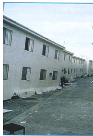
Bild 4: Eingestürztes Apartmentgebäude in Northridge (1994). Im Erdgeschoß untergebrachte Parkgaragen verursachten eine Schwachstelle in der Struktur
