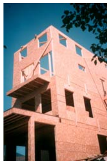
Bild 13: Wandscheibensysteme zur seitlichen Aussteifung von mehrstöckigen Apartment- und Einfamilienhäusern; (a) Sperrholzplatten; (b) OSB Platten; (c) Bretterbeplankung
