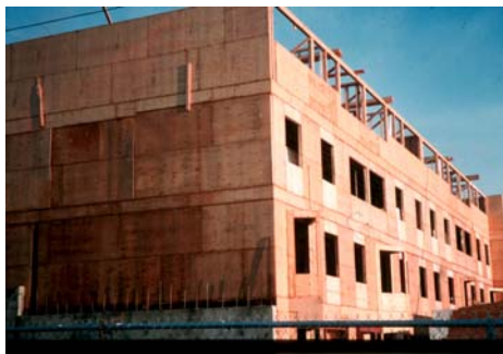
Bild 13: Wandscheibensysteme zur seitlichen Aussteifung von mehrstöckigen Apartment- und Einfamilienhäusern; (a) Sperrholzplatten; (b) OSB Platten; (c) Bretterbeplankung
