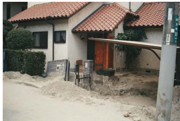
Bild 8: Leichtrahmenhaus in schwer erschüttertem Gebiet in Kobe. Sandauftrieb zeugt von starker Bodenverflüssigung
