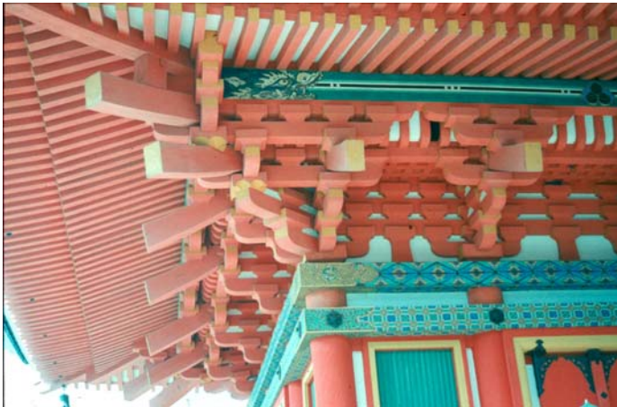
Bild 9: Energieaufnehmendes Balkensystem in japanischen Tempelbauten
