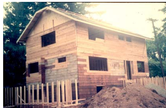
Bild 13: Wandscheibensysteme zur seitlichen Aussteifung von mehrstöckigen Apartment- und Einfamilienhäusern; (a) Sperrholzplatten; (b) OSB Platten; (c) Bretterbeplankung
