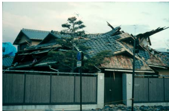
Bild 6: Schwere Ziegeldächer führten zu Zusammenstürzen (Kobe, 1995)
