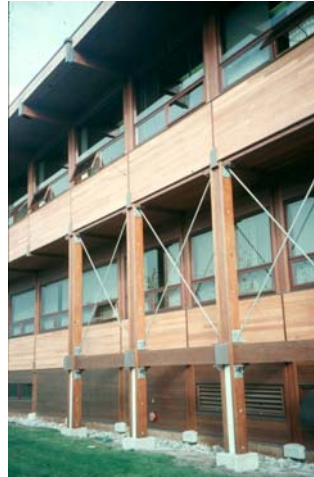
Bild 11: Mit Kopfbändern verstrebt Rahmen
