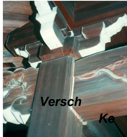
Bild 10: Verkeilte biegesteife Verbindung in Tempelstruktur. Zu beachten sind die vom Erdbeben verursachten Verschiebungen
