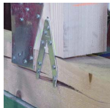
Versuche an ausgesteiften Holzrahmenwänden; Versagen des Schwellenbalkens
