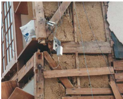
Bild 5 : Eingestürztes Mehrfamilienhaus in Kobe (1995). Schwaches Untergeschoß
