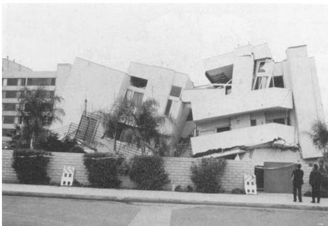
Bild 4: Eingestürztes Apartmentgebäude in Northridge (1994). Im Erdgeschoß untergebrachte Parkgaragen verursachten eine Schwachstelle in der Struktur
