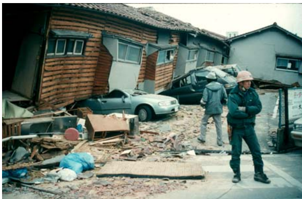
Bild 5 : Eingestürztes Mehrfamilienhaus in Kobe (1995). Schwaches Untergeschoß
