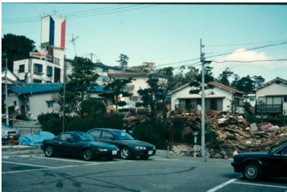
Bild 2: Erdbebenschäden an Holzgebäuden in Kobe (1995)
