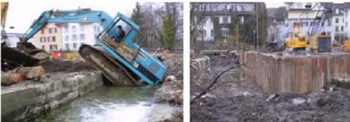
Wasser wird durch Spundwände umgeleitet.
