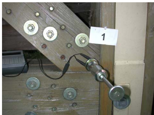
Abbildung 4: Holzfeuchtemessung an einem Fachwerkknoten
