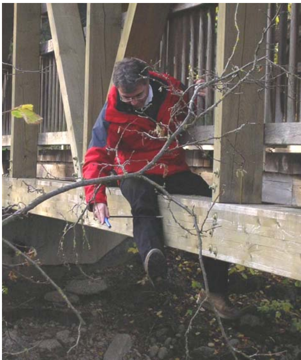
Abbildung 9: Bohrkernentnahme mittels Zuwachsbohrer an einem Untergurt
