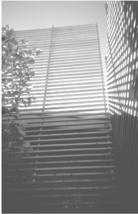
Abbildung 12: Tiefgarage Algunder Kellerei, Meran
