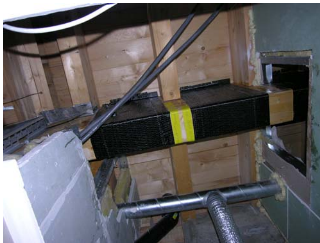
Bild 7: Aufgeklebte CFK-Sheets als Schubverstärkung bei einem Gratsparren.
