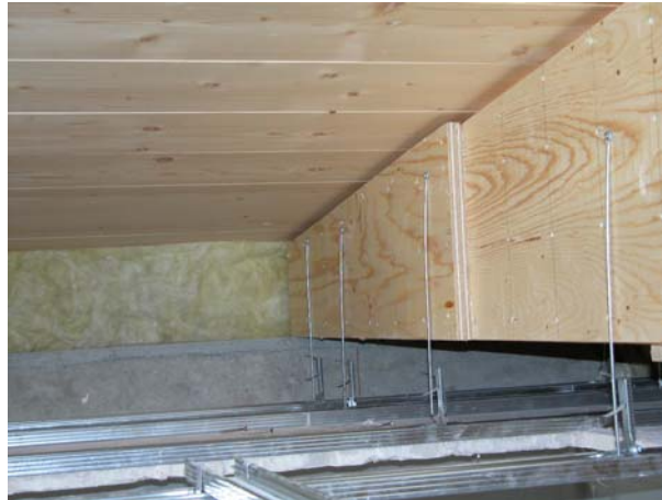
Bild 11: Satteldachträger mit aufgeklebten Furnierschichtholz – Schubverstärkungen.
