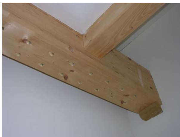
Bild 12: Pfette mit diagonal eingedrehten Vollgewindeschrauben als Schubverstärkung.
