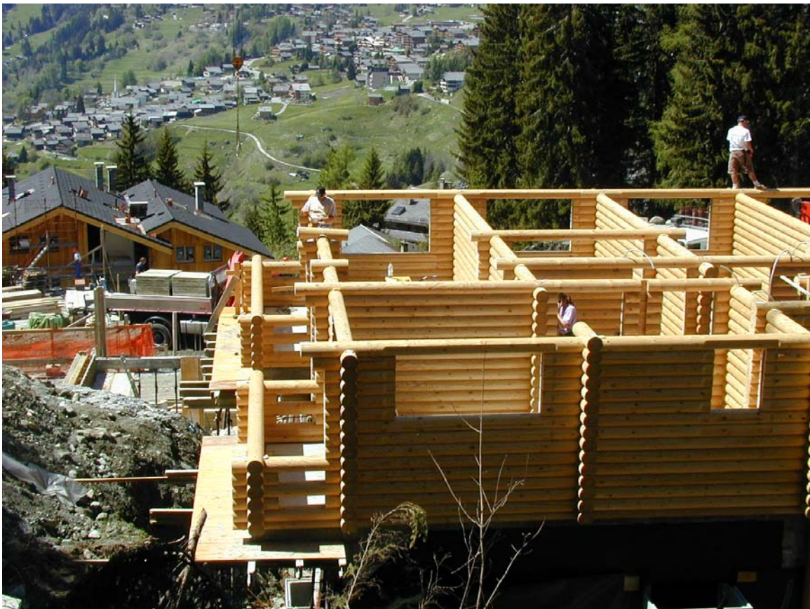
Abbildung 3: Hotelbaustelle in der Schweiz
