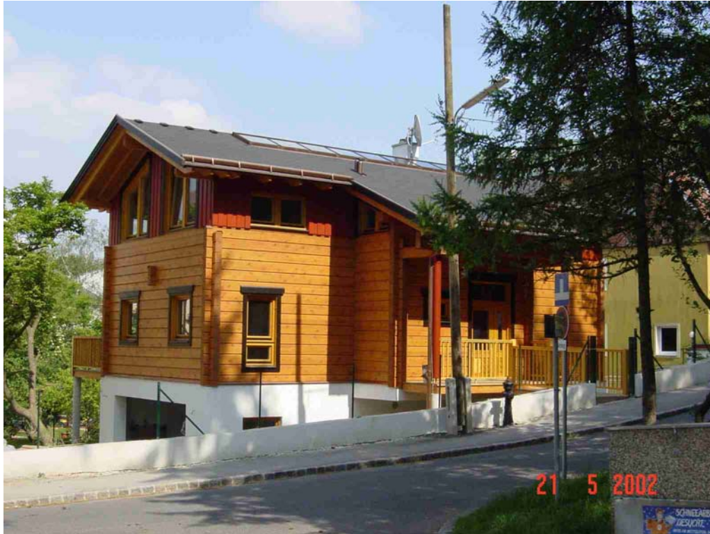
Abbildung 4: Wohnblockhaus in Wien
