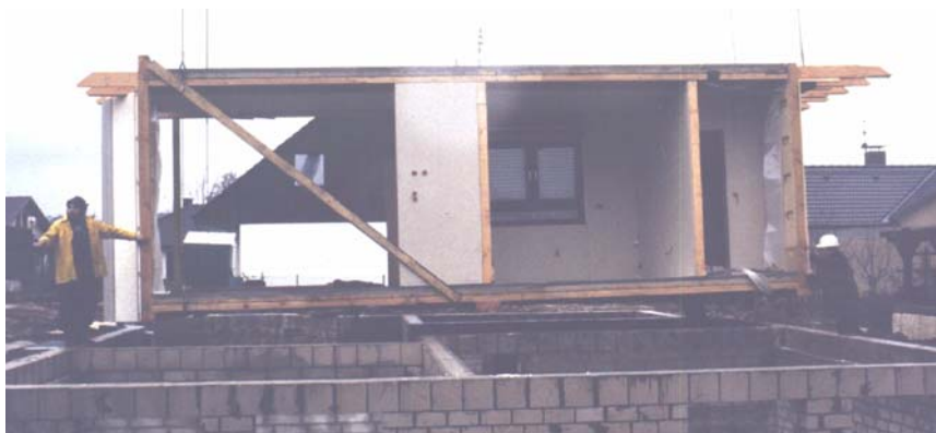
Abbildung 2: Raummodul für eingeschossige Wohngebäude
