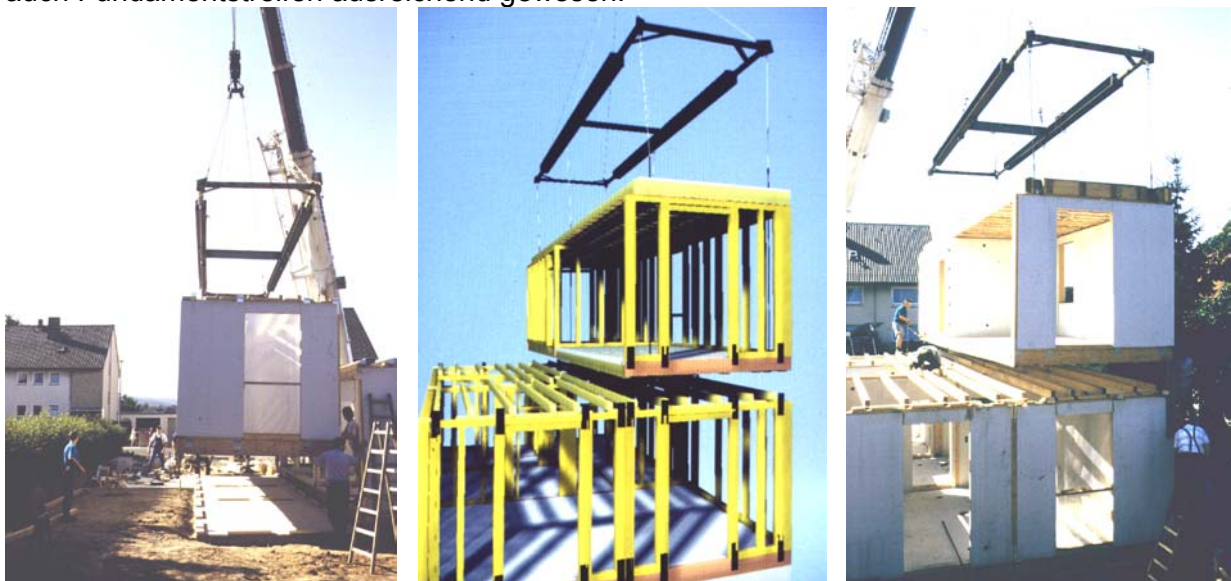
Abbildung 9: Versetzen der Raummodule
