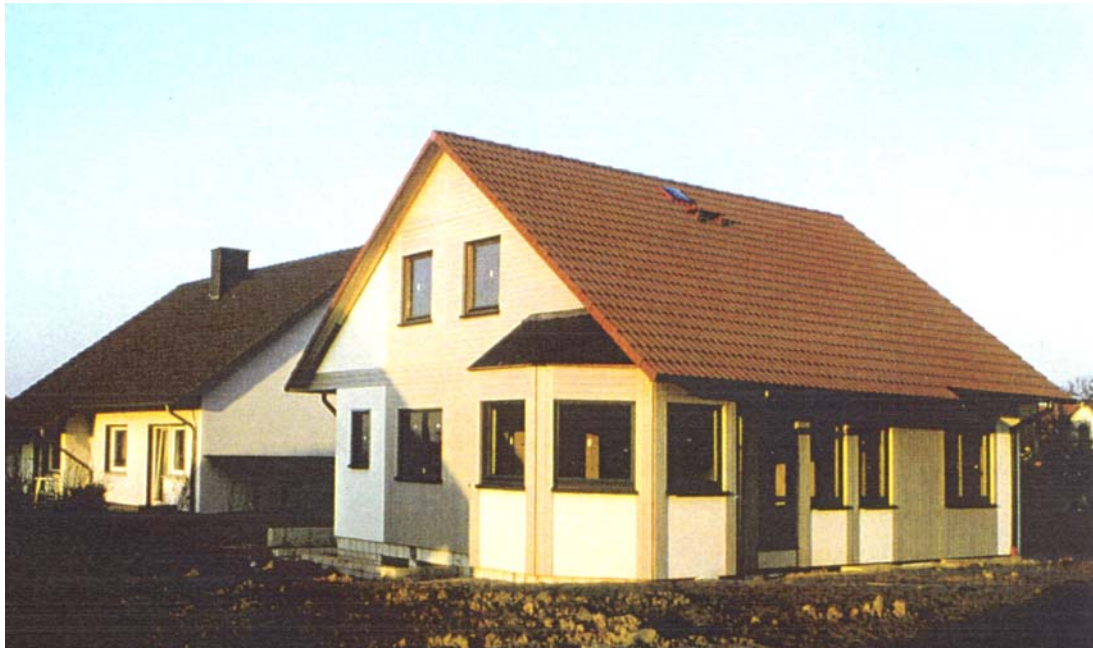
Abbildung 1: Eingeschossiger Prototyp aus Raummoduln der Otto Baukmeier Fertighaus GmbH, Fertigstellung 1989
