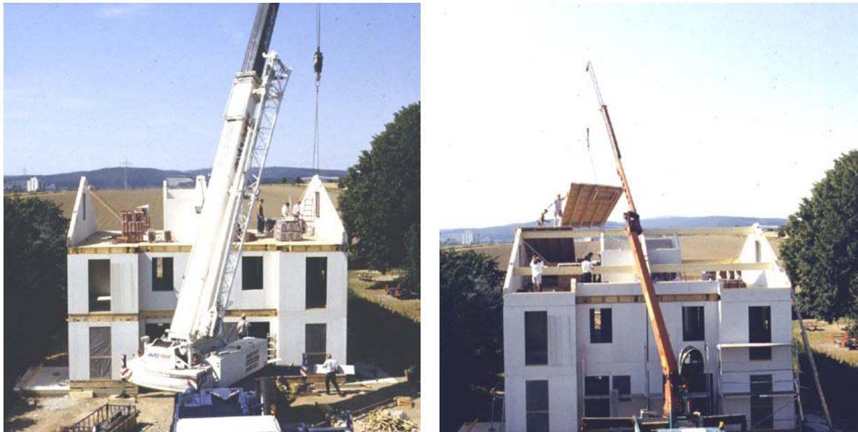
Abbildung 10: Montage der Giebeldreiecke und der Dachtafeln durch die Otto Baukmeier Fertigbau GmbH, Fertigstellung 1994
