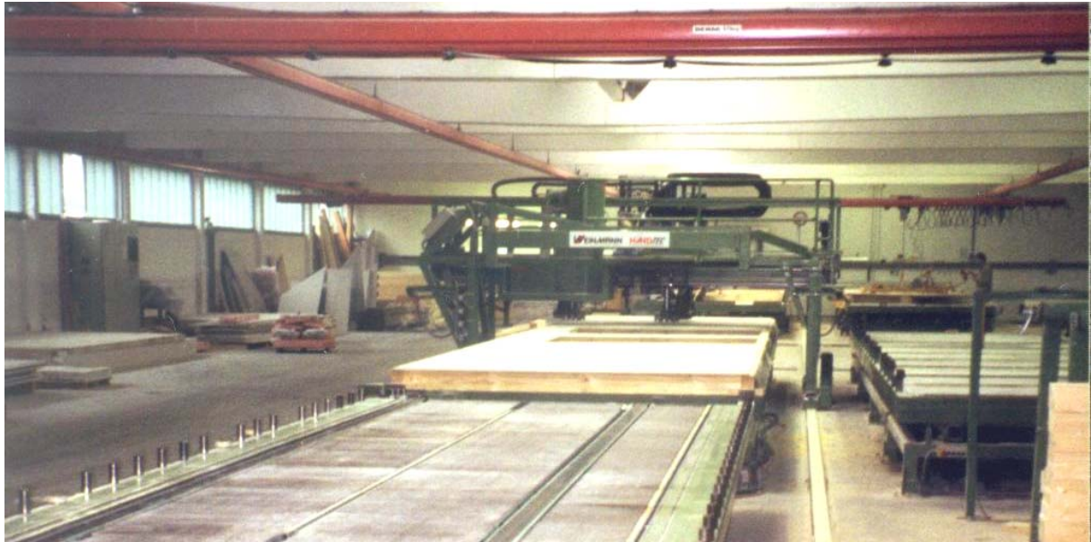
Abbildung 4: Fertigung der Wandtafeln mit CNC-gesteuerter Bearbeitungsbrücke der Otto Baukmeier Fertigung GmbH
