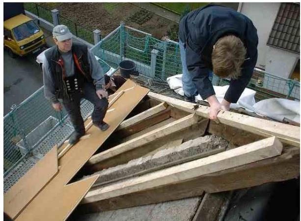
Abb. 3: Alter Dachausbau mit innenseitiger alter Putzschicht einfach aufgerüstet mit Unterdach aus Holzfaserdämmplatten.
