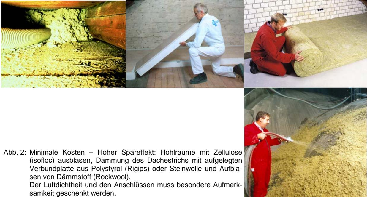
Abb. 2: Minimale Kosten – Hoher Spareffekt: Hohlräume mit Zellulose (isofloc) ausblasen, Dämmung des Dachestrichs mit aufgelegten Verbundplatte aus Polystyrol (Rigips) oder Steinwolles und Aufblasen von Dämmstoff (Rockwool). Der Luftdichtheit und den Anschlüssen muss besondere Aufmerksamkeit geschenkt werden.
