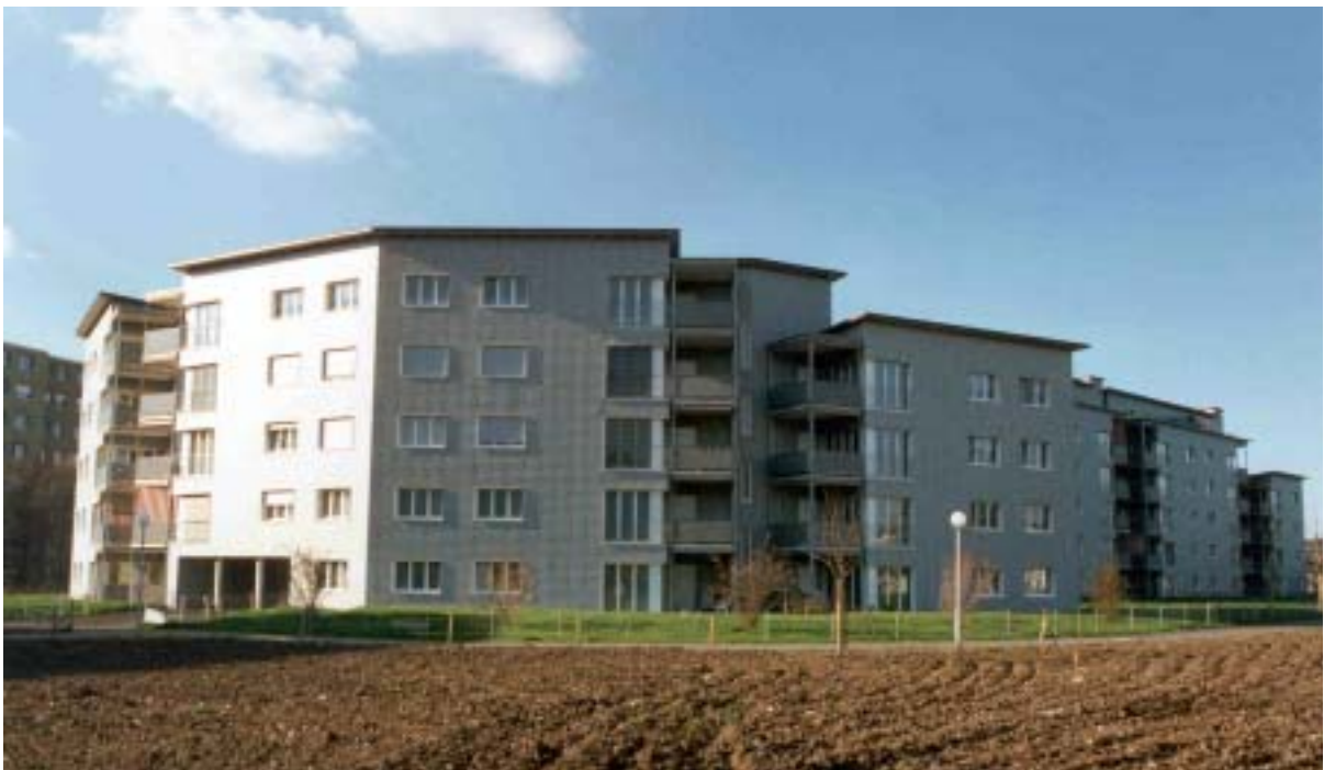
Abb. 11: Überbauung Tell, Aarau
