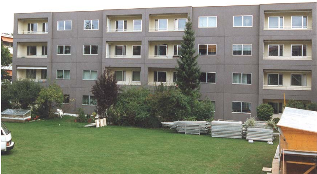
Fertig montierte Fassaden
