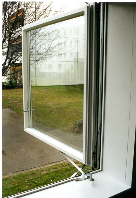
Fensterflügel, nach aussen öffnend
