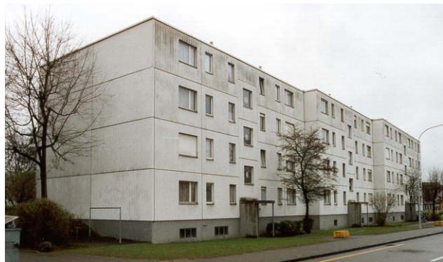
Plattenbau vor der Sanierung
