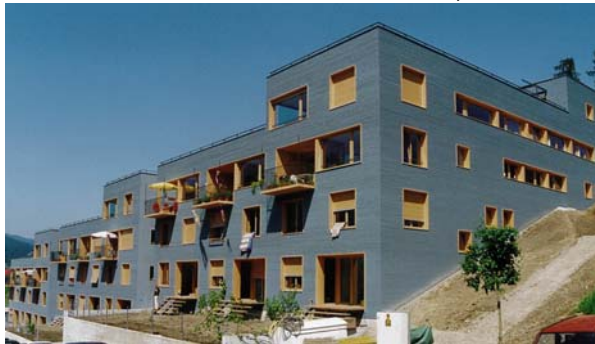
Bild 16: Ansicht von Süd-Ost
