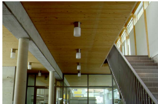
Bild 29: Beton-Unterzug und HBV-Kragarm von 3,0m im Treppenhausbereich
