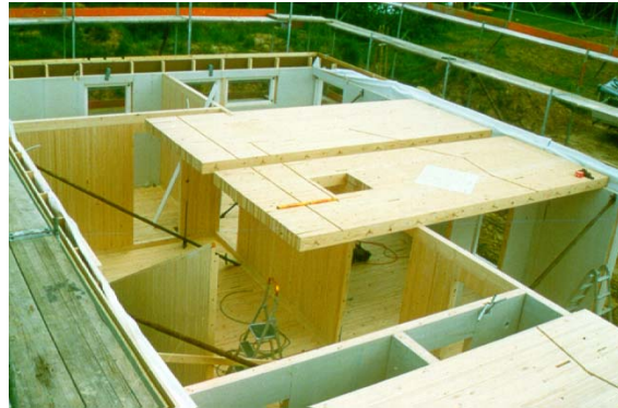
Bild 21: Montage einer BRESTA-Decke
