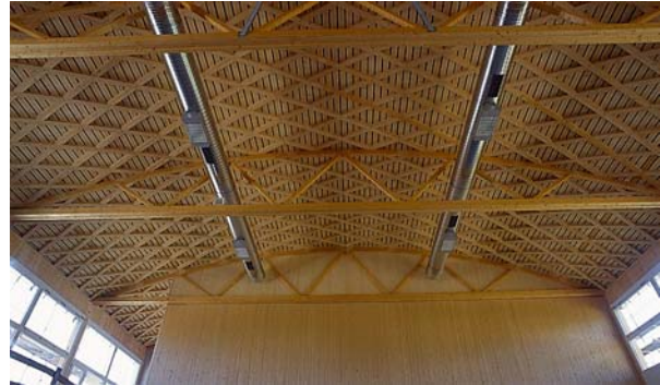
Bild 23: Mehrzweckhalle Plasselb (FR): Brettstapelwände und Tonnendachschale in Brettrippenbauweise.
