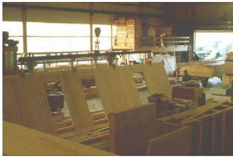
Bild 3: Vorfertigung von grossen Wandelementen im Werk
