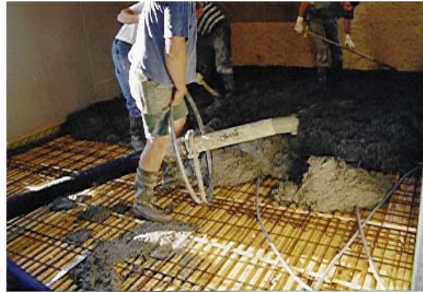
Bild 27: Brettstapeldecke beim Einbringen des Betons mit der Betonpumpe. Trotzdem der Beton ohne Zwischenfolie direkt auf den Brettstapel aufgebracht wird tropft bei richtiger Ausführung kein Betonwasser durch.
