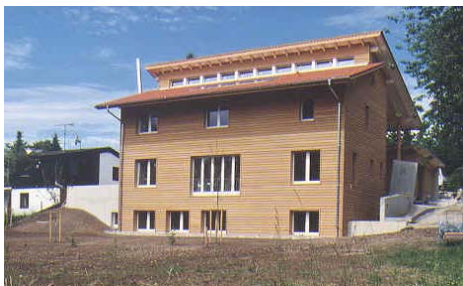
Bild 5: EFH Armgart in Schondorf (D): Das erste Einfamilienhaus Deutschlands mit gedübelten Wänden und Decken.
