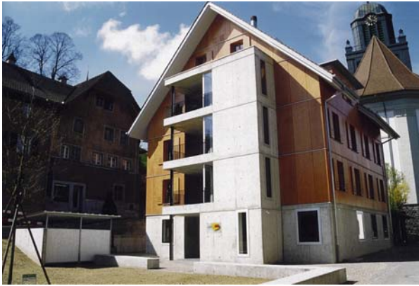
Bild 26: Viergeschossiges Mehrfamilienhaus Chilegass 15 in Willisau (LU) Decken als Holz/Beton Verbundkonstruktion, Wände als Holz-Rahmenkonstruktion
