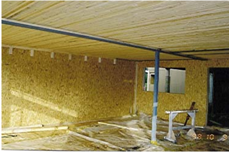
Bild 9: Rohbauaufnahme: später verkleidete Brettstapeldecken auf Rahmenbauwänden
