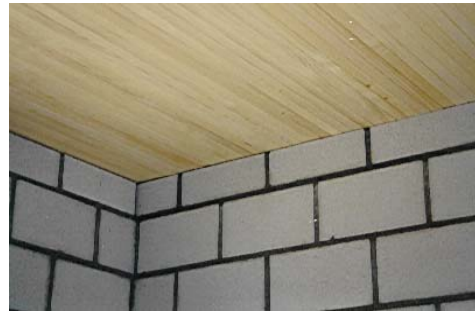
Bild 10: Sichtbarbelassene Brettstapeldecken auf Kalksandsteinwand
