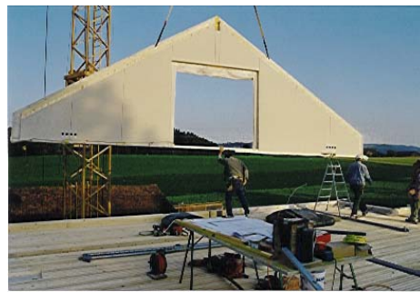
Bild 4: Montage eines Einfamilienhauses aus gedübeltem Brettstapel.
