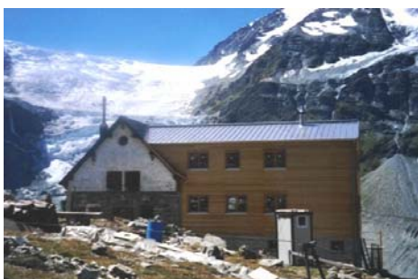
Bild 7: Die Wände, Decken und das Dach der SAC-Hütte Turtmann (VS) bestehen aus Lärchenholz-BRESTA.
