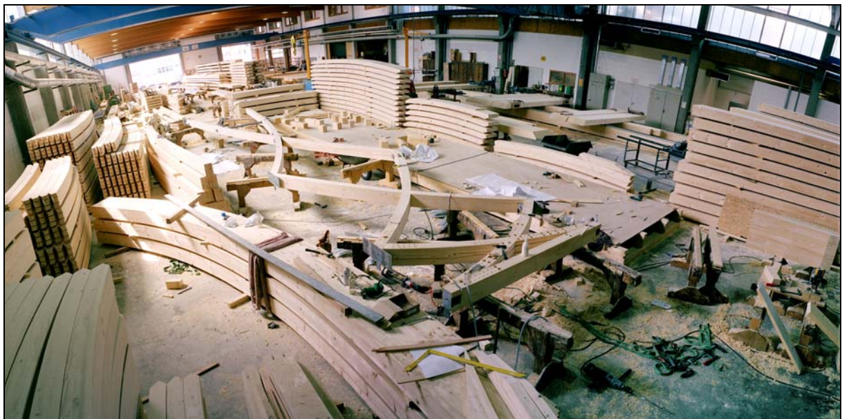
Abbildung 6: Vorfertigung eines Holzsegmentes in der Werkhalle.
