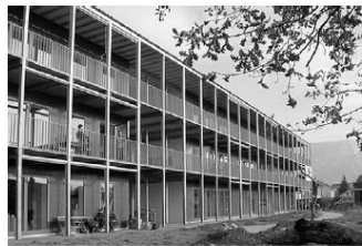
Plan-les-Ouates/GE, MFH mit Genossenschafts- wohnungen (2007) Atba – Stéphane Fuchs architecte et collabora- teurs, Genf EDMS SA, Petit-Lancy Racines Carrées Charpente, Meinier
