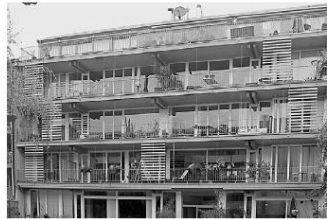
Basel/BS, MFH Amerbachstrasse (2006) Simon Rösch, Basel, und Seiberth + Moser GmbH, Arlésheim Lauber Ingenieurbüro für Holzbau, Luzern Hector Egger Holzbau, Langenthal
