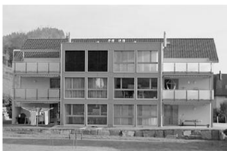
Escholzmatt/LU, MFH Althusmatte (2007) Peter Portmann Architekturbüro GmbH, Escholzmatt Pirmin Jung Ingenieure für Holzbau GmbH, Rain ARGE ·hölziges aus escholzmatt, Escholzmatt
