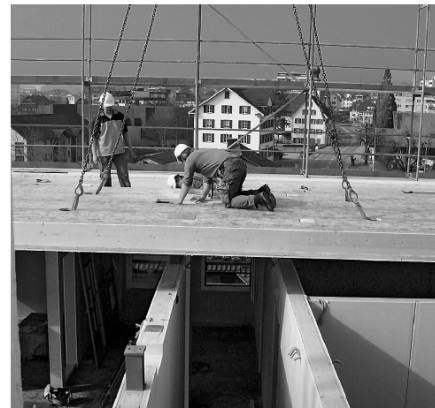
Gemäss statischem Konzept (unten) sind die aussteifenden Wandbereiche schubfest mit den Decken verbunden worden (oben).
