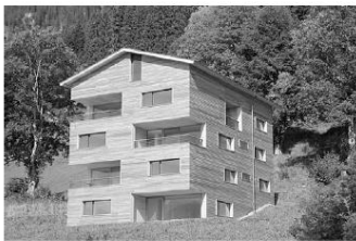
Beatenberg/BE, Bebauung Silberhorn (2007) Fahrni Heinz, Steffisburg Timbatec GmbH, Steffisburg Künzi + Knutli AG, Adelboden
