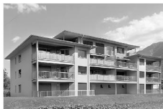
Fully/VS, MFH Morisod (2006) W.+R. Leuenberger AG, Rain Pirmin Jung Ingenieure für Holzbau GmbH, Rain Morisod et Fils SA, Troistorrens
