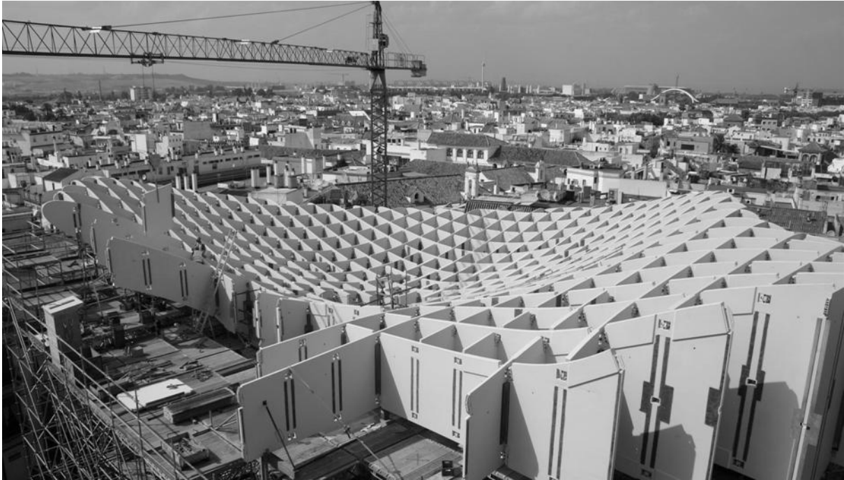
Abbildung 17: Blick über die Baustelle des Metropol Parasol und die Altstadt von Sevilla
