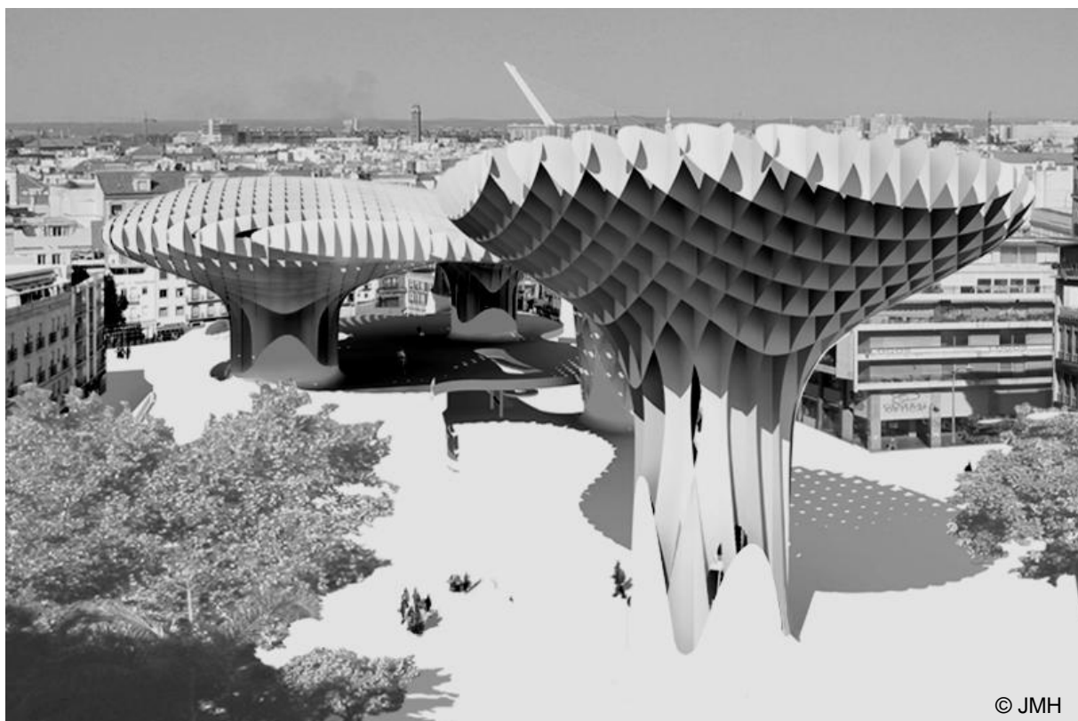
Abbildung 1: Rendering der freigeformte Verschattungskonstruktion aus Kerto-Q Furnierschichtholzplatten mit einer 2-3 mm dicken Polyurethan Beschichtung
