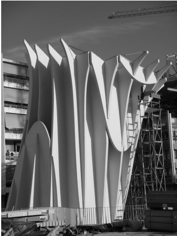
Abbildung 8: Stamm im Bau
