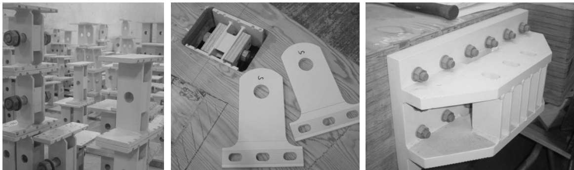
Abbildung 9: Der standardisierte Knoten für den Normalkraft- und Momentenanschluss ist in 15 Grundtypen unterteilt und wird je nach Bauteilgröße in 450 verschiedenen Größen verwendet.
