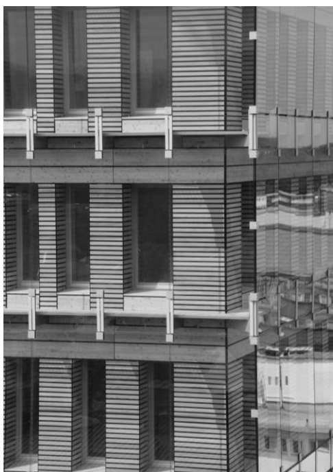
Abbildung 3: Die fertiggestellte Fassade der Regelgeschosse
