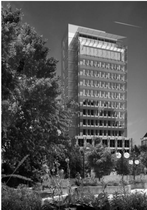
Abbildung 2: Visualisierung – Blick auf das sanierte Hochhaus
