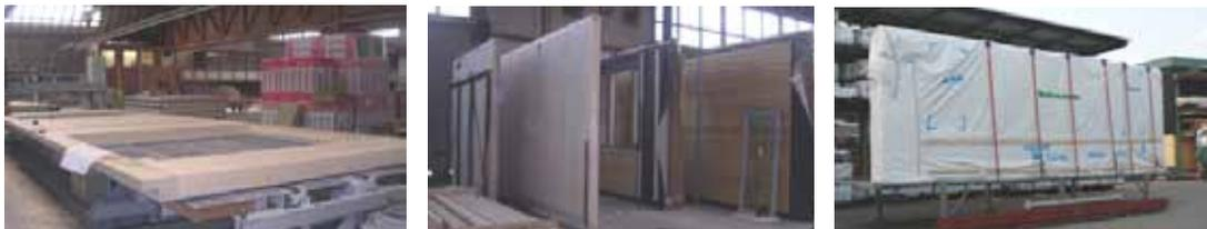
Bei unserem Pilotprojekt wurden 4 Geschoße in 4 Tagen aufgestellt. Speziell im dichten städtischen Raum ist dies von Bedeutung, da die Anwohner dadurch nur sehr kurz von großem Baugerät belästigt werden. Der darauf folgende Ausbau erfolgt mit Kleinfahrzeugen und entsprechend weniger Lärm.
