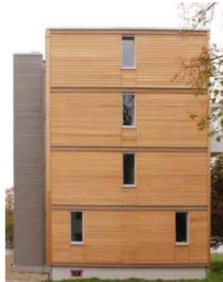
Das gesamte Gebäude einschließlich Aufzugsschacht und Loggien besteht aus Holz und ist in sich selbst ausgesteift.
