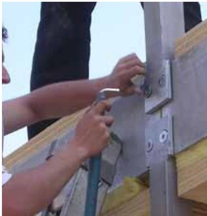
Der gezeigte Knotenpunkt ist der Schlüssel für die schnelle Errichtungsmethode. Die einfachen Kopf- bzw. Fußlaschen an den Stützen dienen zur Lagesicherung für die Deckenelemente bzw. die Stützen darüber und genauso als vertikale und horizontale Zugverankerung.
