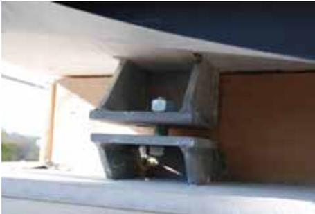
Mit dem gezeigten Knotenpunkt werden die leichten Holzwände gegen Abheben bei Horizontallast durch Wind gesichert
