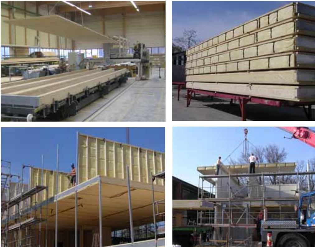
Ein Montagetrupp kann damit bis zu 1500 qm Rohbaufläche in mehreren Geschoßen übereinander in einer Arbeitswoche aufstellen. Decken und Wände sowie die Rahmen der Glas-Fassaden bestehen aus Holz lediglich die Fassadenstützen sind aufgrund der großen Lasten im Schulbau aus Stahl. Die Gebäude können in feuerbeständiger Bauweise errichtet werden.
