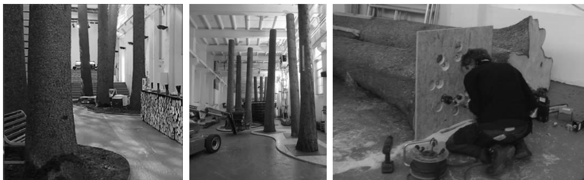
Abbildung 12: Fertiger Messeraum (links), Baumstämme bei Ausgestaltung der Messe (Mitte), Befestigung der Baumstämme an der Bodenplatte mit IdeFix (rechts)
