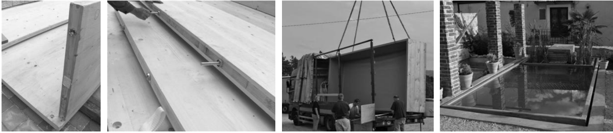
Abbildung 14: IdeFix in den Stirnseiten (links) und beim Anschluss des Bodens (Mitte links), Pool beim Transport (Mitte rechts), Fertiger Pool (rechts)
