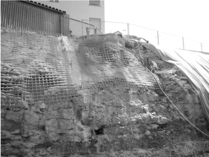
Abbildung 10: Beispiel Sicherung mit Baustahl und Spritzbeton.
