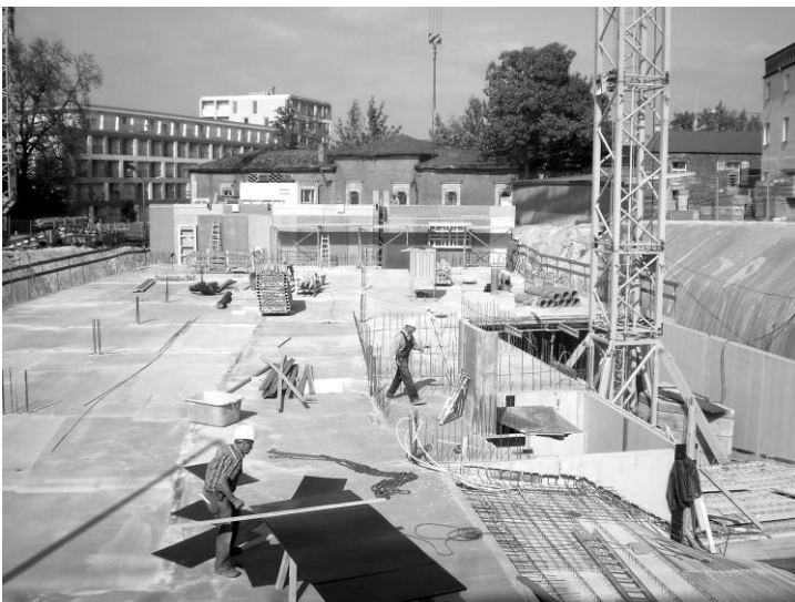
Abbildung 11: Logistische Leistung aufgrund beengter Bausituation. Der Baukran steht im Gebäude.
