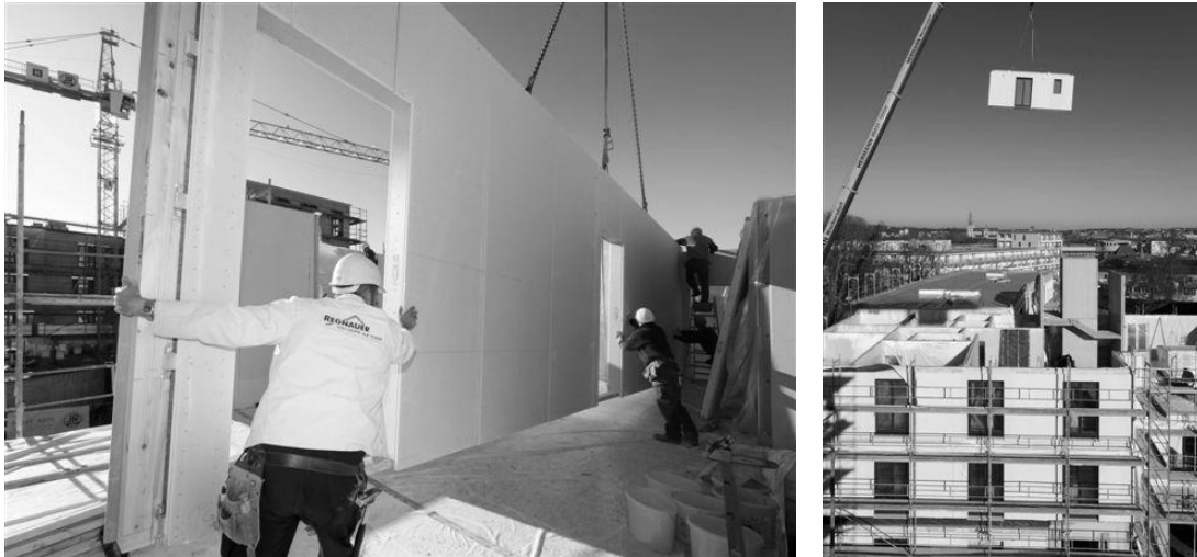
Abbildung 14 und 15: Montage des Gebäudes
