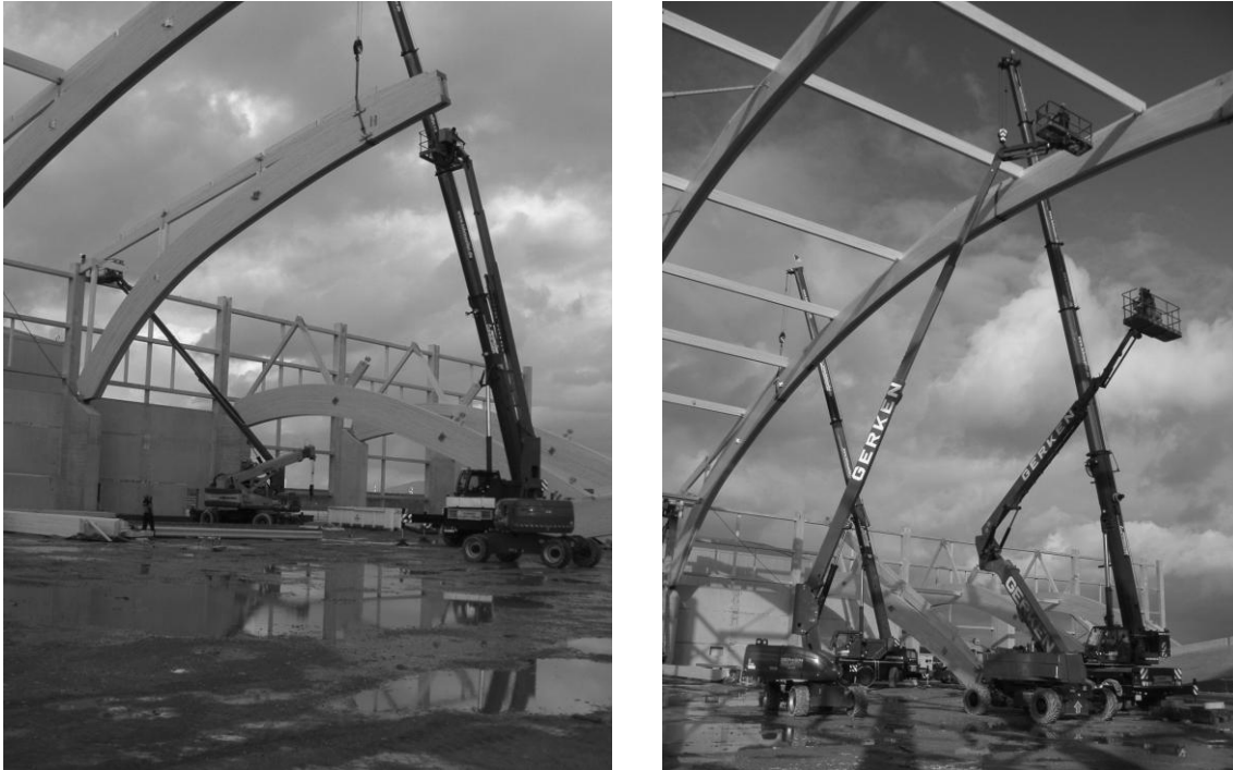
Abbildung 5: Holzbau Ammann, D-Weilheim: Montage der Bogenelemente.
