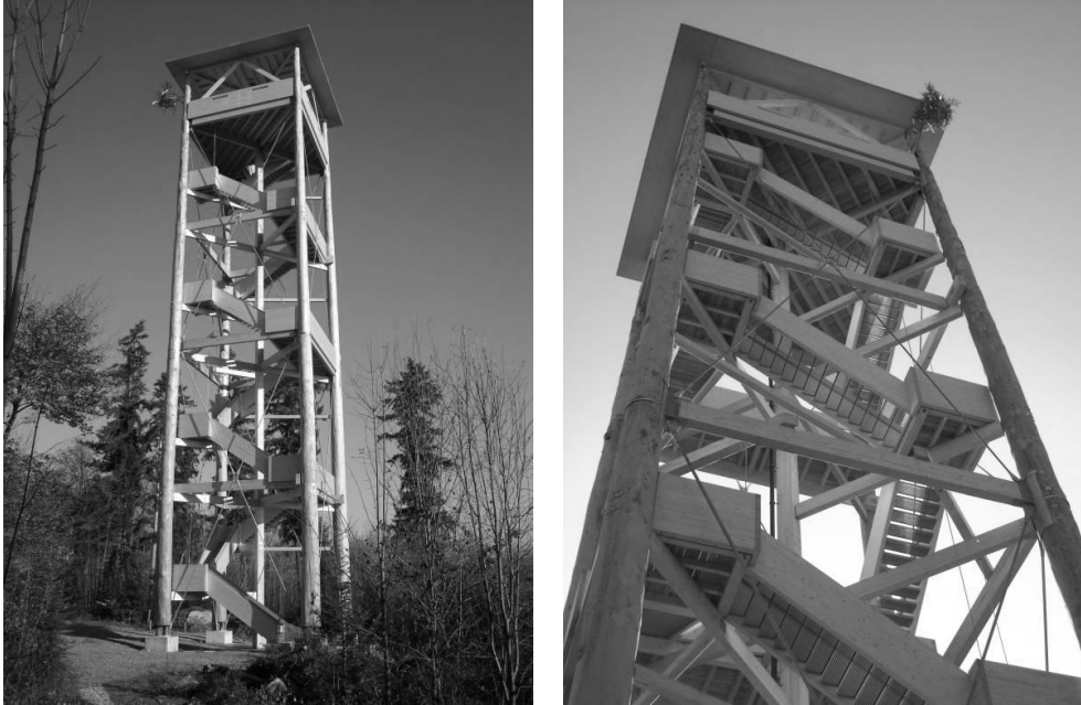
Abbildung 5 und 6: Der Lysser Aussichtsturm nach der Fertigstellung
