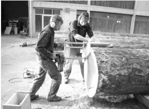
Abbildung 19: Schlitzen der Rundholzstützen
