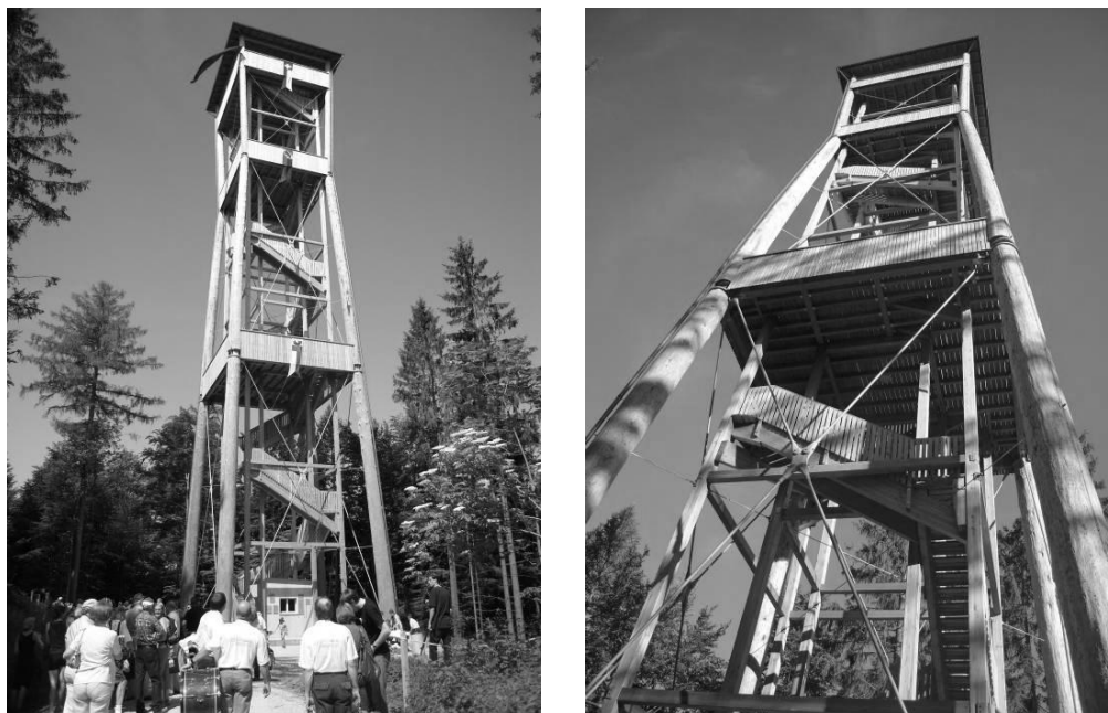
Abbildung 12 und 13: Der Chutzenturm nach der Fertigstellung
