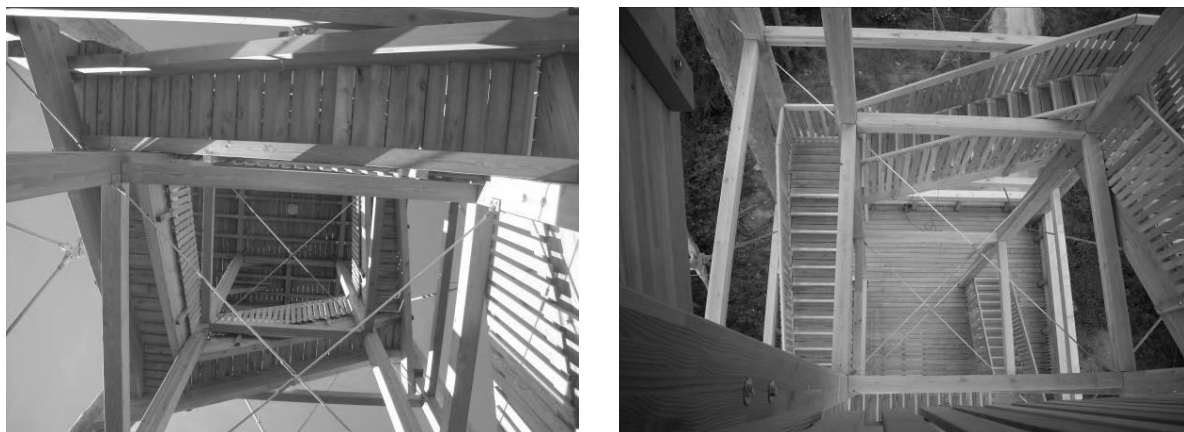
Abbildung 25 und 26: Stabilisierungsstäbe für den Treppenkern bzw. Treppenkonstruktion
