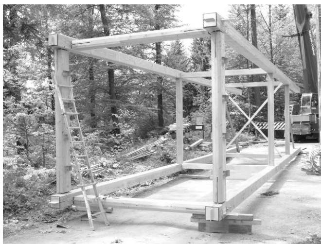
Abbildung 28: Innere Treppenhausstützen als Modul vorgefertigt
