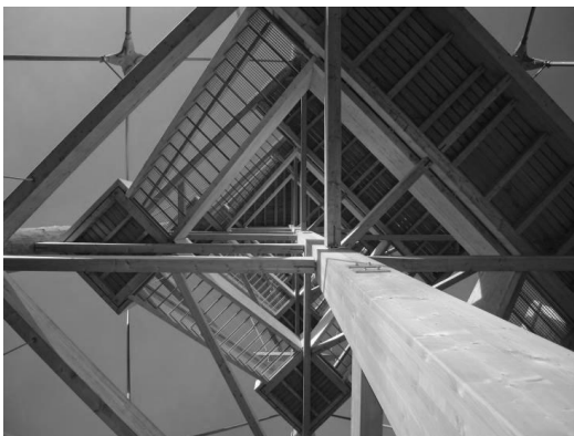
Abbildung 8: Anschlüsse an die Mittelstütze (Sicht von unten nach oben)
