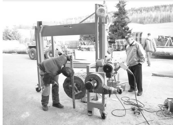
Abbildung 20: Kappen der Rundholzstützen
