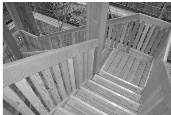
Abbildung 18: Zweiteilige Eichentritte mit Metallkante
