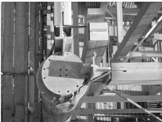
Abbildung 21 und 22: Stützenübergang im Bereich Zwischenplattform
