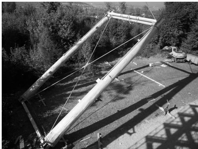
Abbildung 10: Montage eines der beiden Stützenjochs
