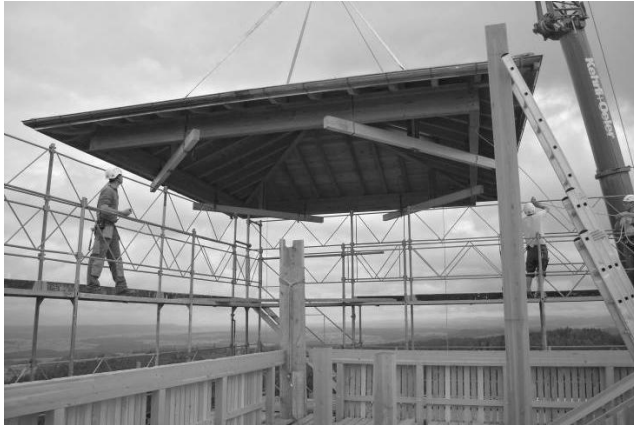
Abbildung 29: Montage des vorgefertigten Daches
