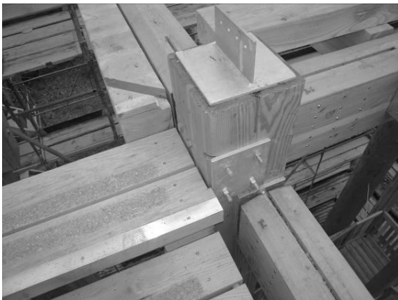
Abbildung 23 und 24: Fugenausbildung in Anschlussbereichen
