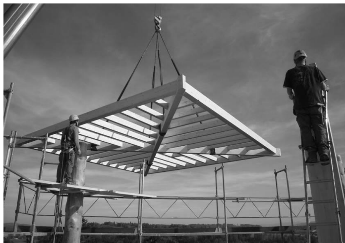
Abbildung 11: Einpassen des Dachtragwerkes an die Rundholzstützen bevor das Dach ganz vorgefertigt wurde
