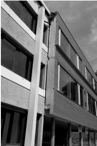
Abbildung 6 (li): Betonfertigteile des Bestandes wurden durch neue, hochdämmende vorgefertigte Holzelemente ersetzt. Arch. Heinz Plöderl. Bild: © by Fritz Klaura
