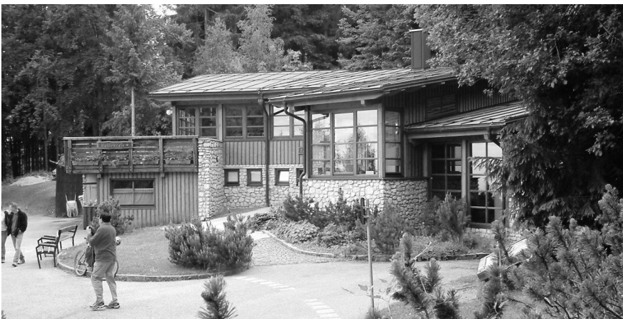
Abbildung 7: Betriebsgebäude der Obir Tropfsteinhöhlen in den Karawanken. Das örtlich im „Überfluss“ vorhanden Material Holz wurde, wie schon jeher, als Baustoff genutzt. Gefertigt vom örtlich ansässigen Holzbaumeister.
