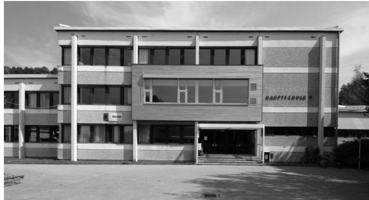
Abbildung 5 (re): Thermische Sanierung der Hauptschule in Schwanenstadt (OÖ). Eine Referenzklasse wurde mit der neuen Fassade versehen. Arch. Heinz Plöderl. Bild: © by Fritz Klaura
