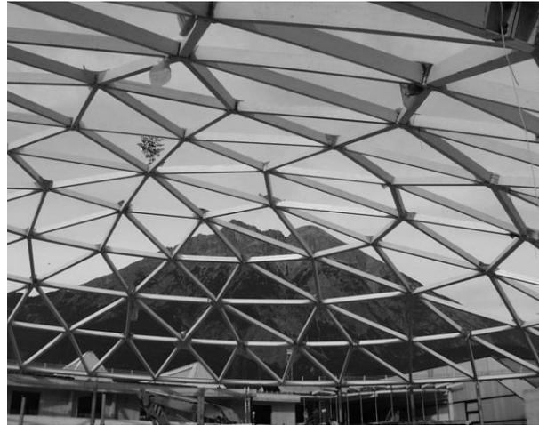
Abb. 5: freigespannte Kuppel
