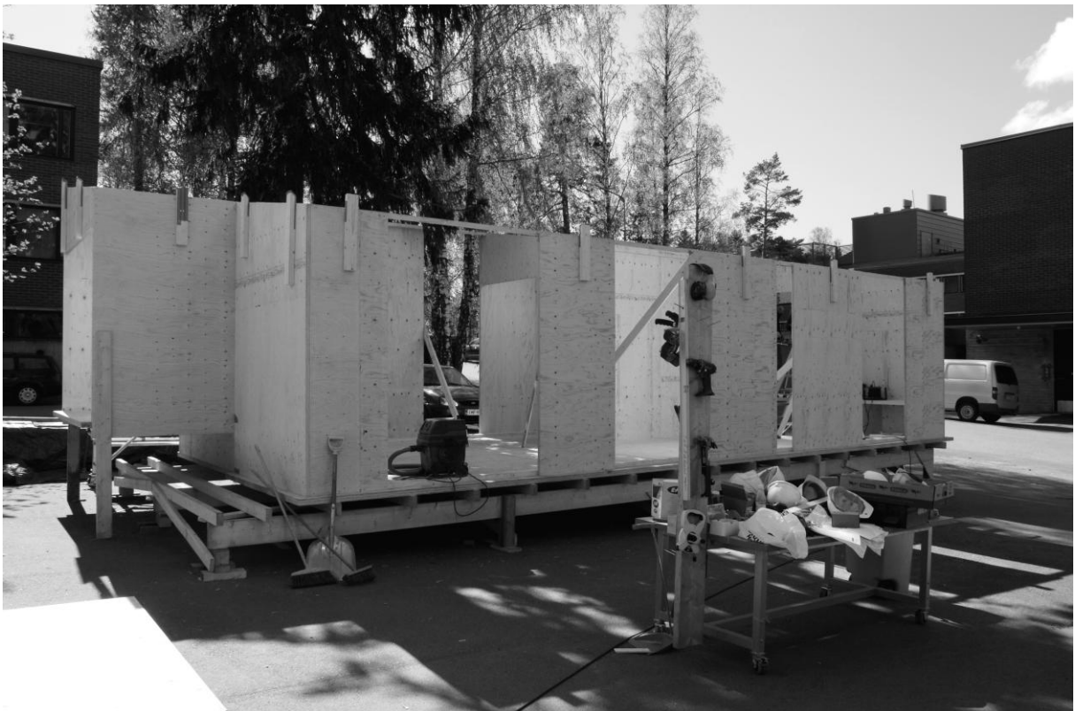
Figures 2A, 2B: Luukku House Kerto LVL frame
