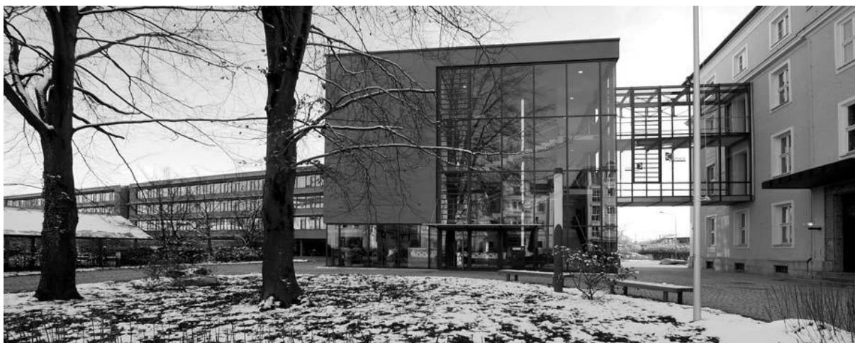
Bild 1: Hauptzollamt Rosenheim, Ansicht Neubau
