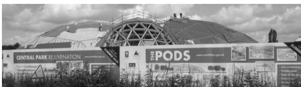
Abbildung 24: Montagezustand: ca. Mitte Oktober 2010 (AWA architects)
