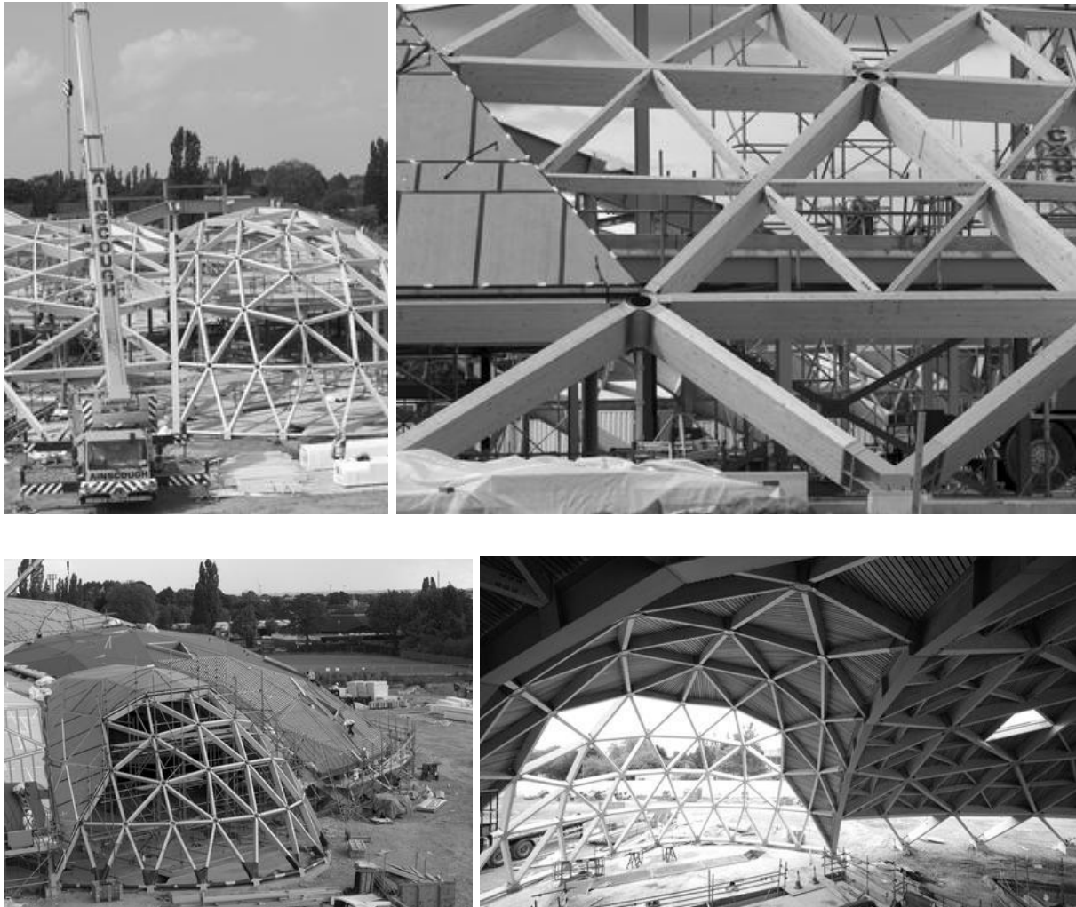
Abbildung 19 – 23: Weitere Montageeindrücke (AWA architects/B&K Structures Ltd.)
