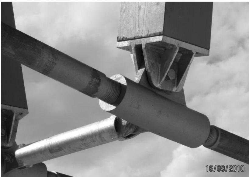
Abbildung 13: Knoten der Unterspannung
