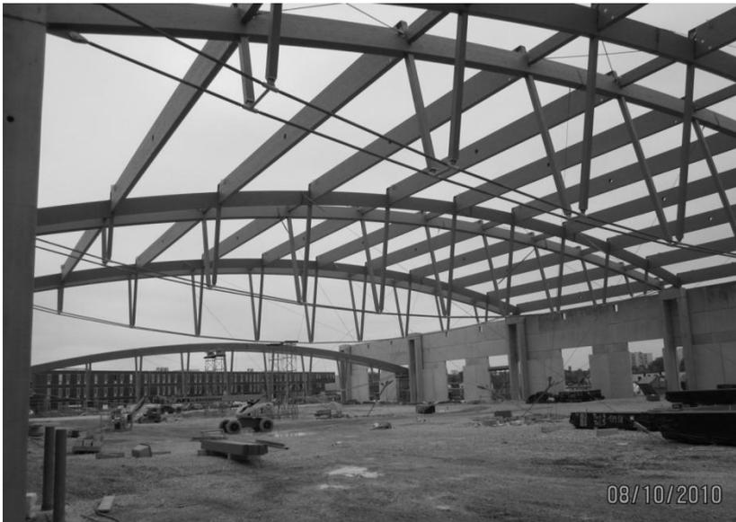
Abbildung 12: Innenhof 1 kurz vor Fertigstellung der Dachtragkonstruktion
