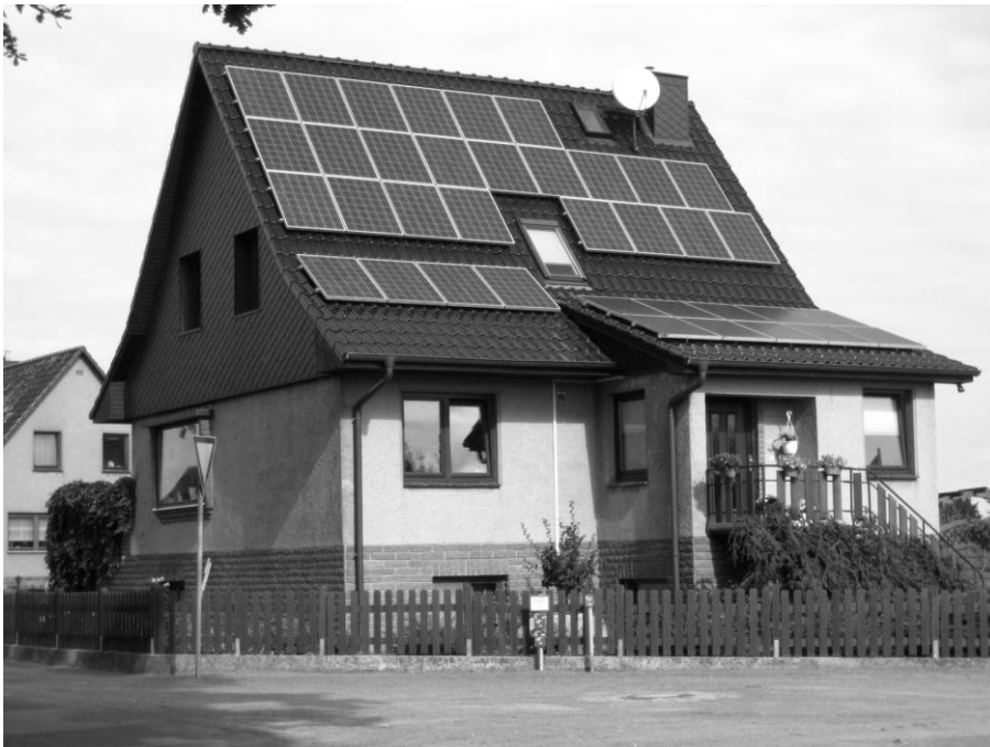
Misslungene Bestückung eines Einfamilienhauses mit PV-Modulen: In SCHÖNER WOHNEN kein Thema, es gibt nur Positiv-Berichterstattung
