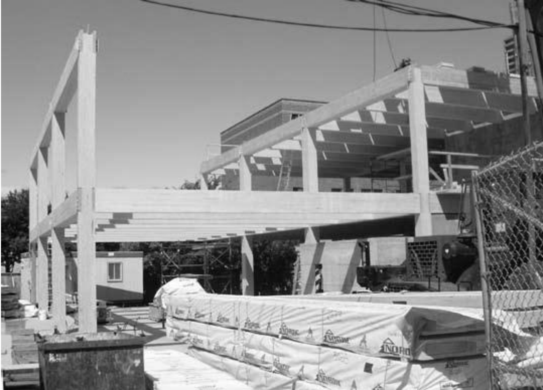
Figure 8 : Montage des portiques
