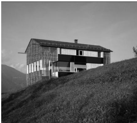
Planung Reinhold Hammerer Holzbau Wucher, Foto Klomfar
