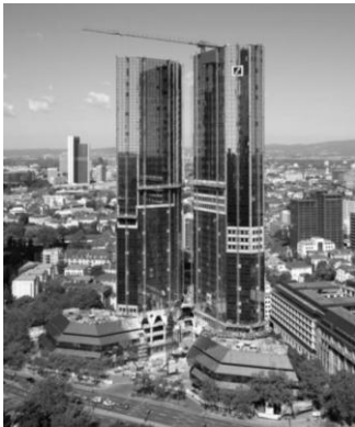
Umbau der Taunusanlage – 2009
