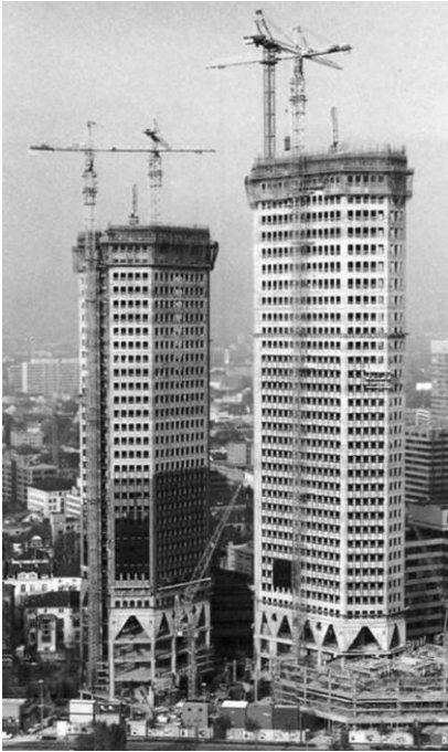
Das "tube in tube" Verfahren - 1981
