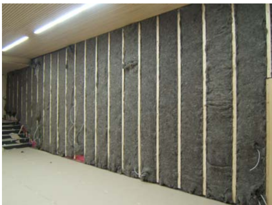
Abbildung 8: Schafwolle in der Installationsebene
