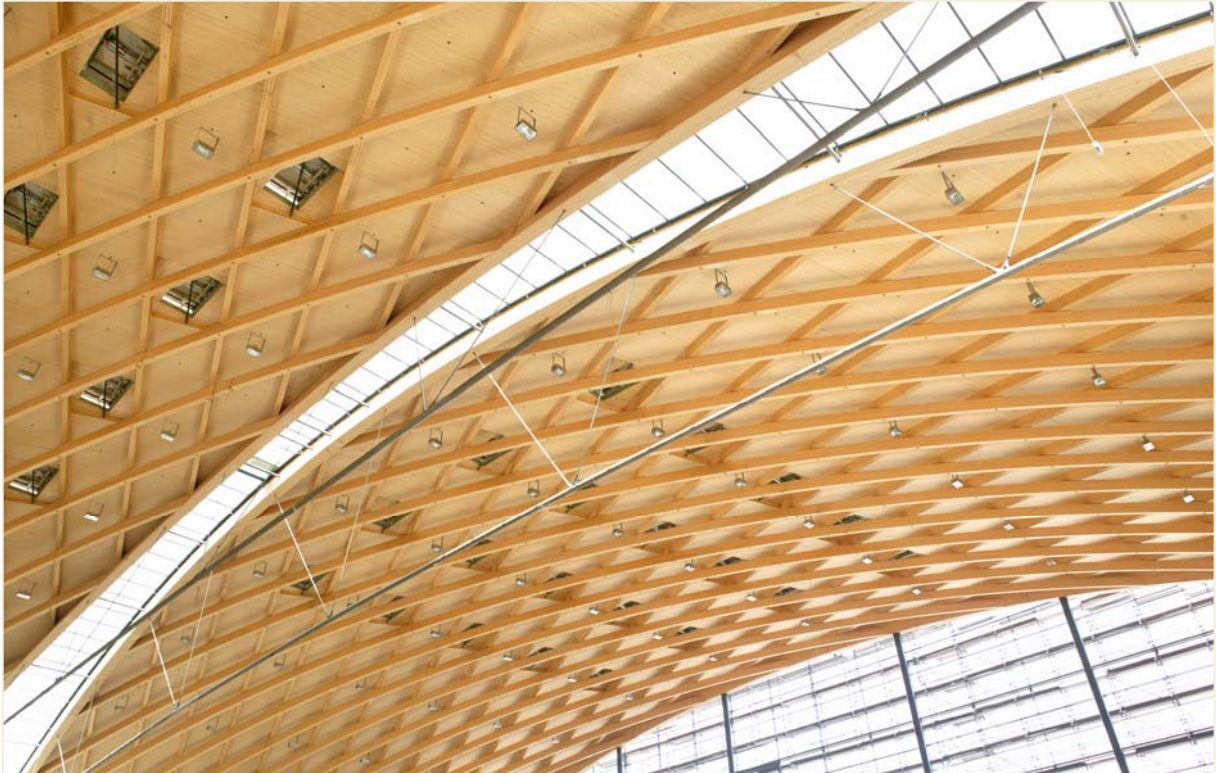
Abbildung 9: Neue Messe Karlsruhe (Holzbau – WIEHAG, Architekt: Gerber Architekten)
