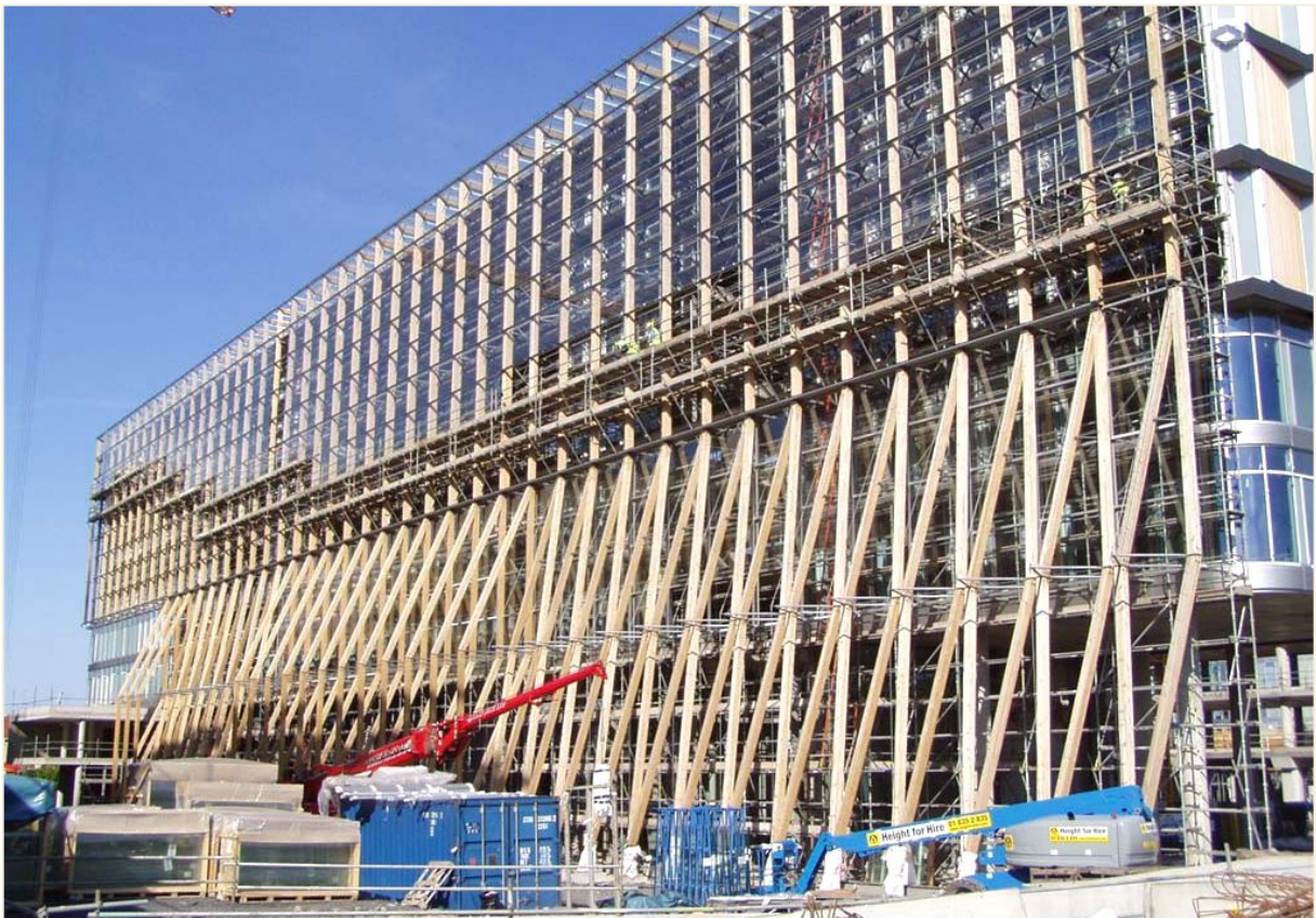
Abbildung 8: Elm Park Dublin (Holzbau – WIEHAG, GU SEELE Austria, Architekt: Bucholz McEvoy)
