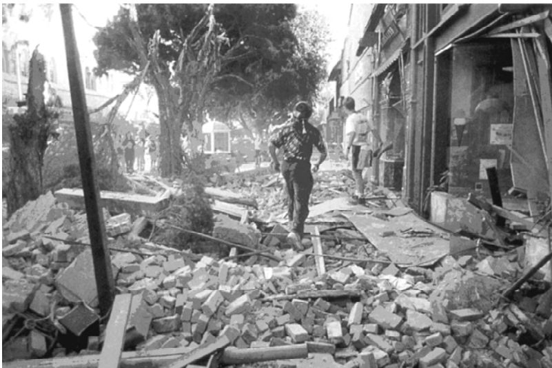
Abbildung 2: Gefährdung durch herabgefallene massive Fassaden (Loma Prieta 1989)
