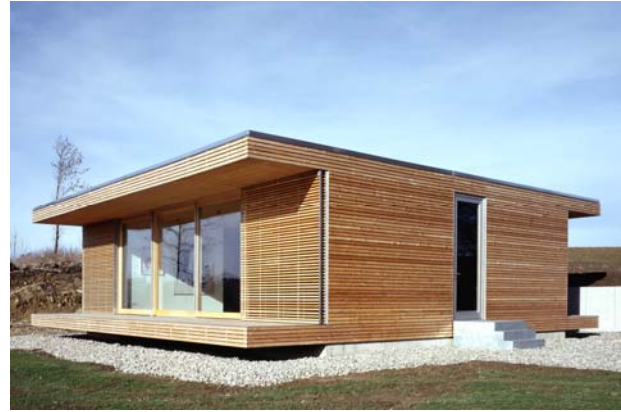
Abbildung 6: Atelierhaus in Rottweil (Arch. a360, Hamburg)
