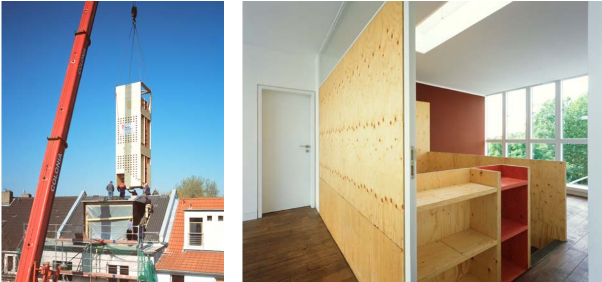
Abbildung 11: Umbau in Köln (Arch. Lüderwaldt Verhoff, Köln)
