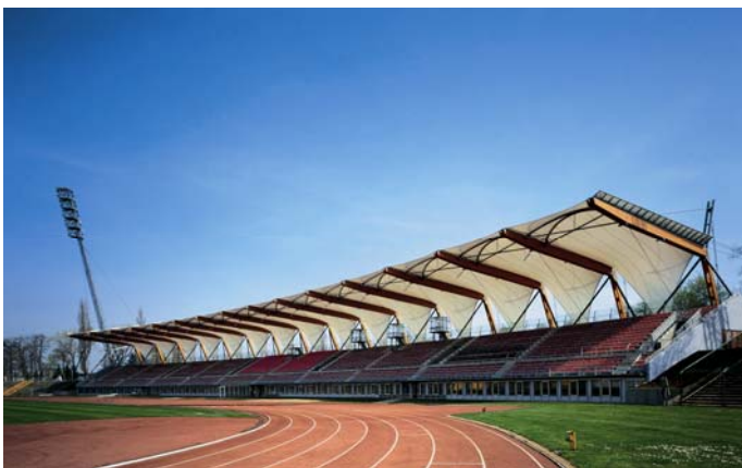
Abbildung 2: Tribünenüberdachung in Erfurt (Arch. Ulrich Zimmermann, Murrhardt)
