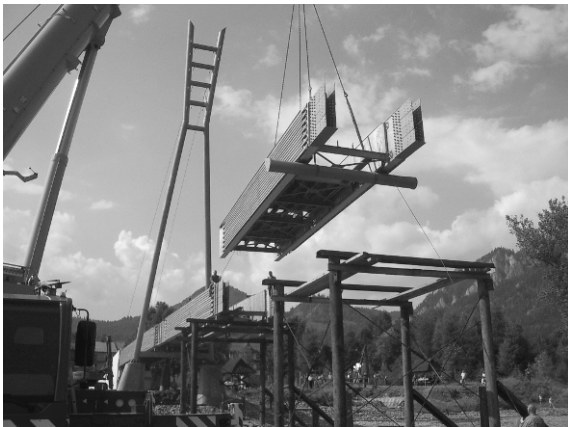
Abbildung 24: Montage der Überbauelemente auf Hilfsgerüsten
