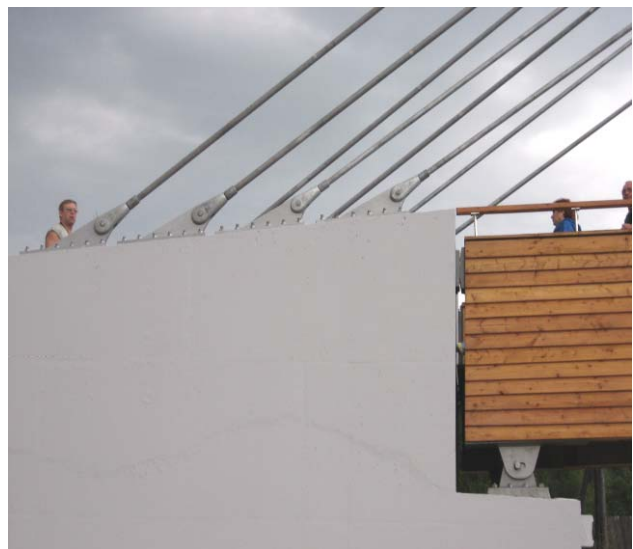
Abbildung 15 und 16: Verankerung der Zugstangen am Widerlager auf der polnischen Seite
