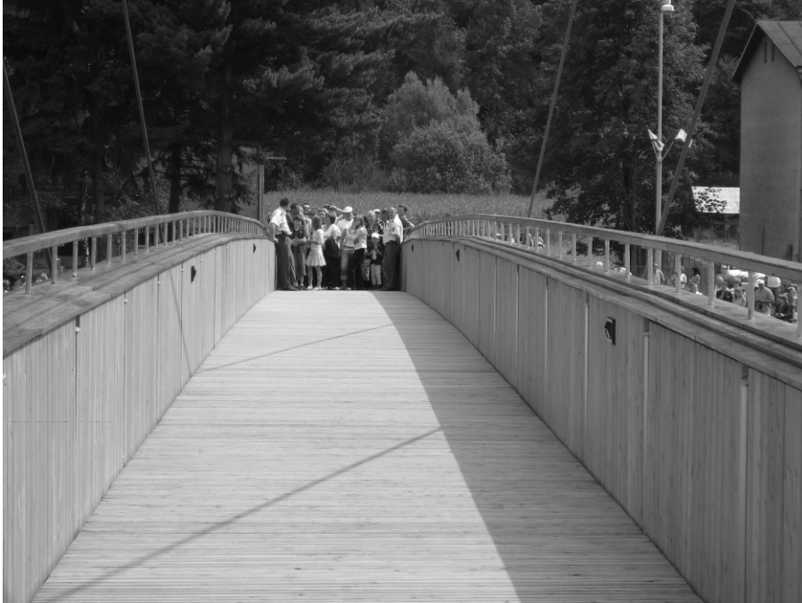
Abbildung 17: Blick durch die Brücke, innere Verkleidung; obere Abdeckung und Handlauf
