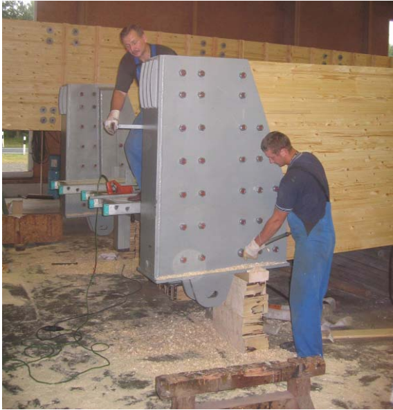
Abbildung 20: Vormontage der Auflagerkonstruktion
