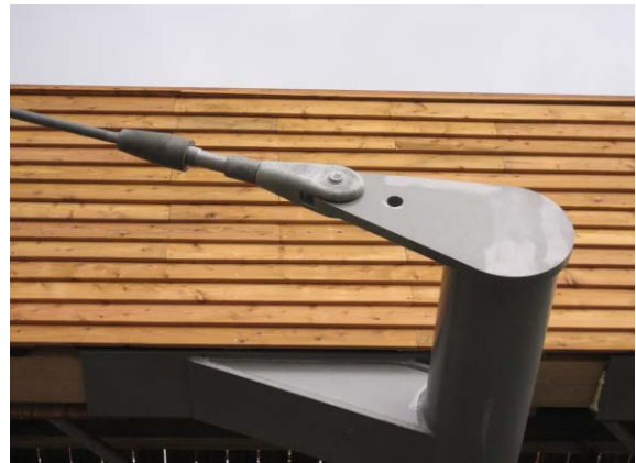
Abbildung 14: Anschluss der Seile am Querträger
