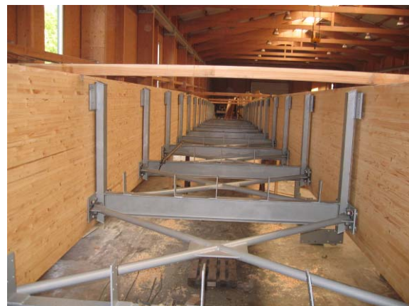
Abbildung 19: Aussteifungsrahmen und eingeschweißter Windverband
