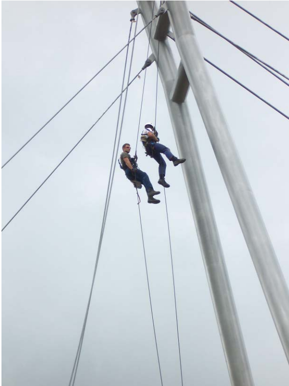
Abbildung 27: Montage der Seile am Pylonkopf
