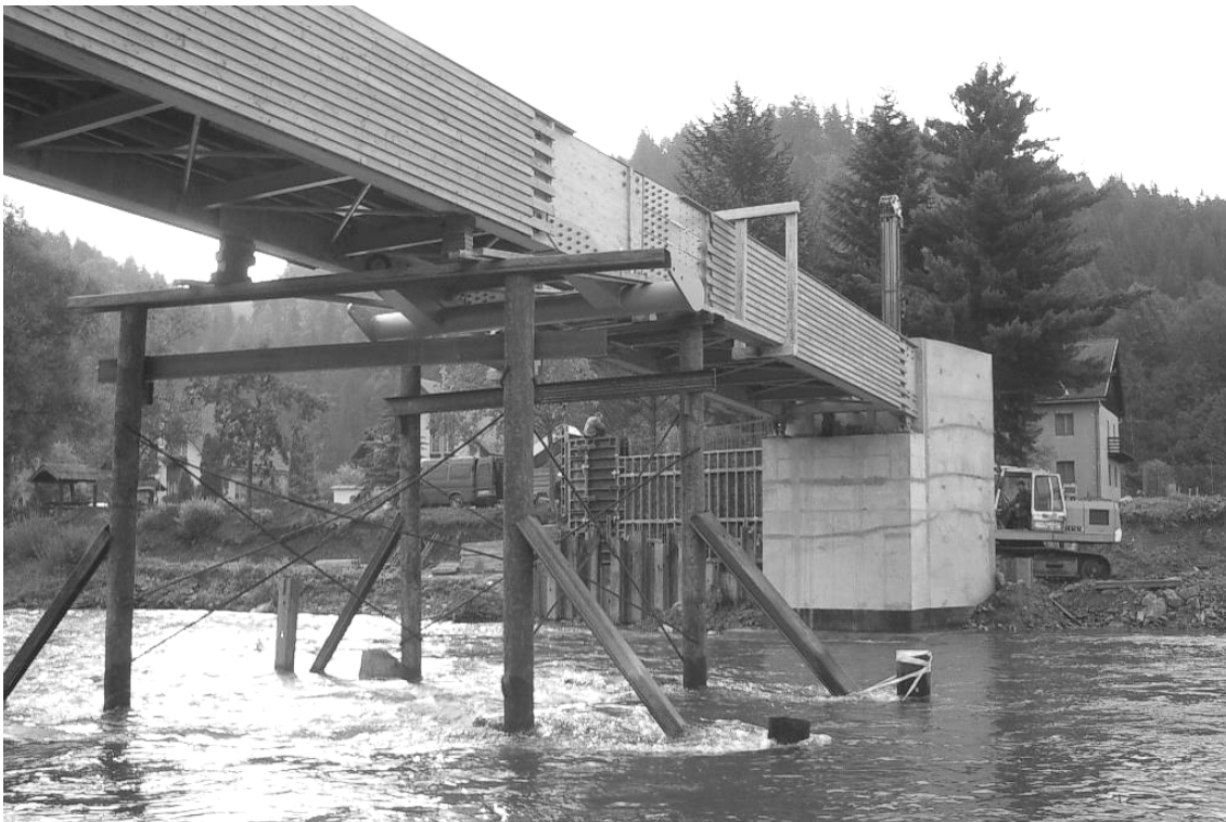
Abbildung 26: Das letzte Überbauelement ist montiert
