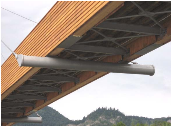
Abbildung 13: Querträger am Brückenüberbau
