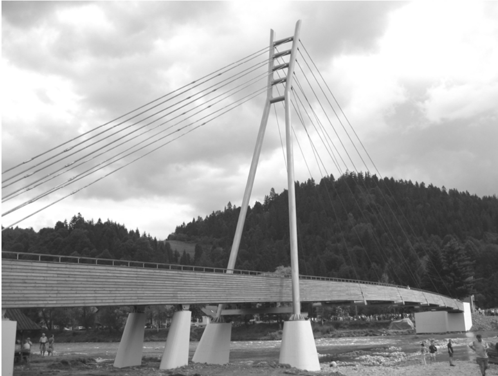
Abbildung 31: Blick auf die fertige Brücke aus Polen
