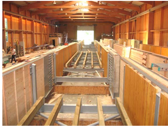
Abbildung 21: Teilweise angebrachte Verschalung und Längsträger für den Bohlenbelag
