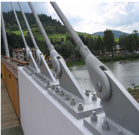
Abbildung 15 und 16: Verankerung der Zugstangen am Widerlager auf der polnischen Seite
