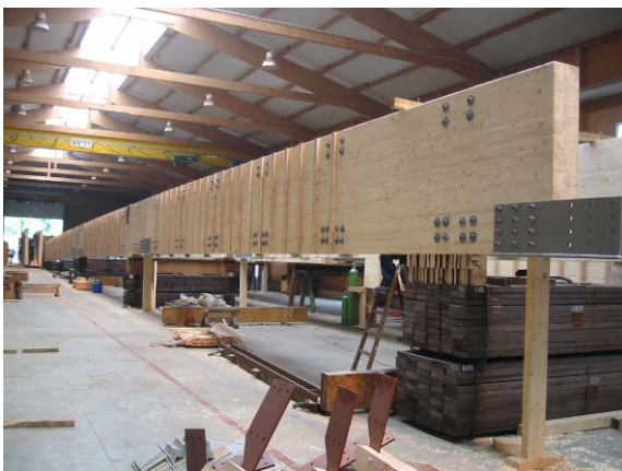
Abbildung 18: Längsträger mit Lattenunterkonstruktion für die spätere Verschalung
