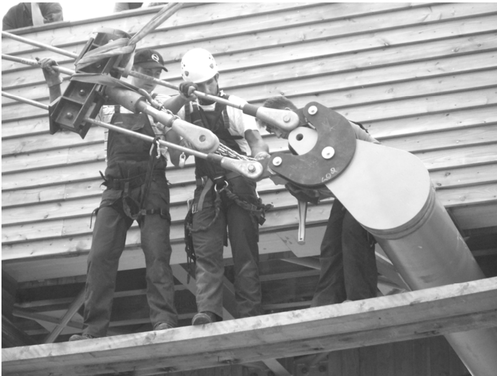
Abbildung 28: Montage der Seile an den Querträgern
