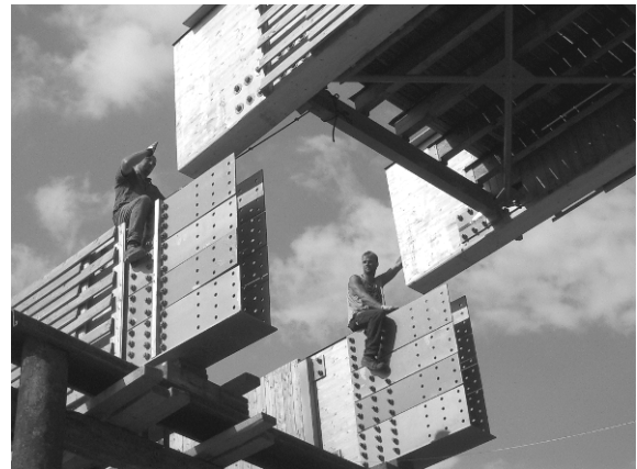
Abbildung 25: Zusammenführung eines Elementstoßes
