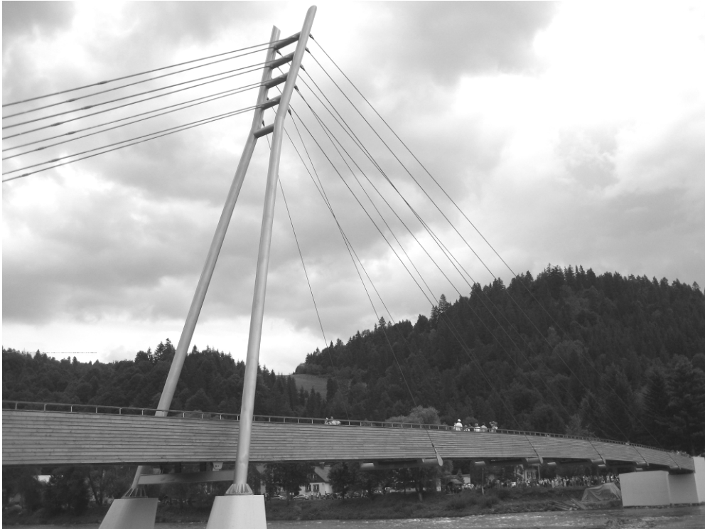
Abbildung 7: Blick auf die fertige Brückenkonstruktion
