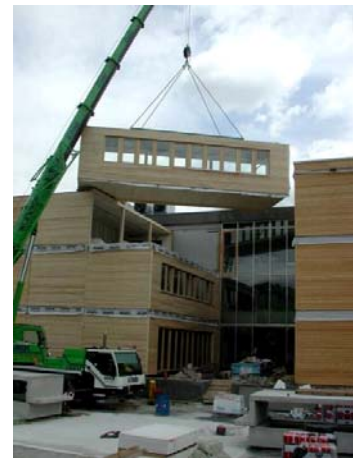
Versetzen eines Moduls
