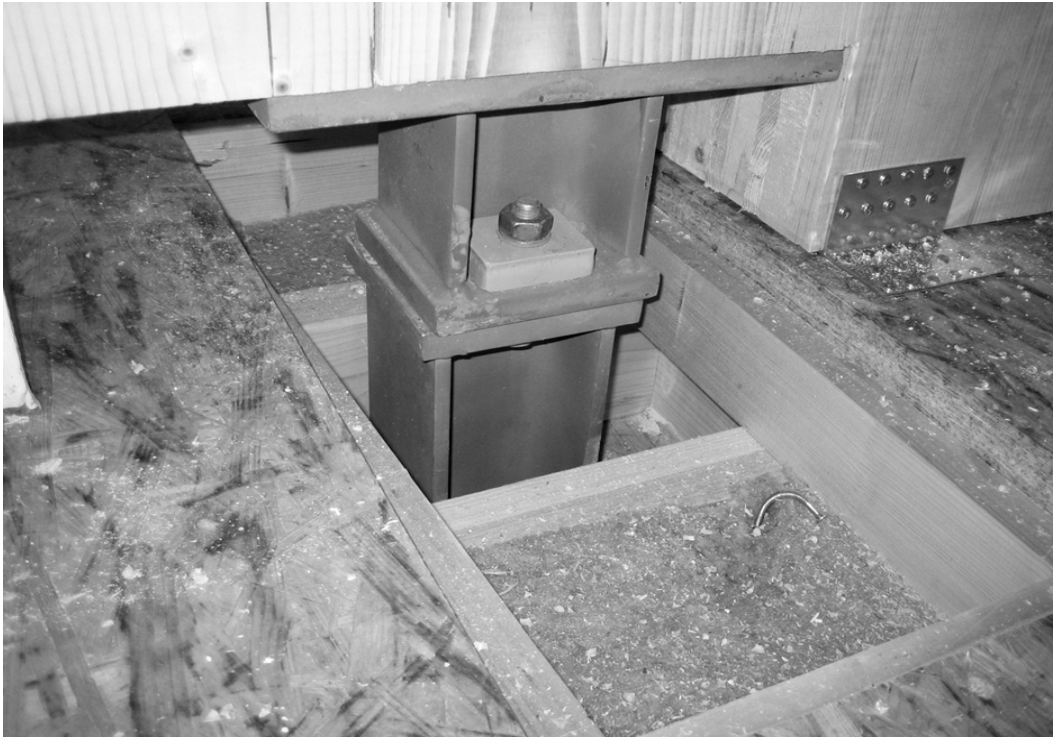
Abbildung 8: Ausführung der Verbindung von aussteifenden Wänden
